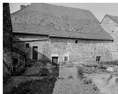
Façades postérieures (détail). Phot. Bernard Lardière IVR43_19767000509X
