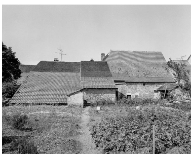
Façades postérieures. Phot. Bernard Lardière IVR43_19767000508X
