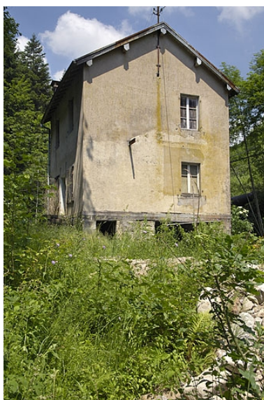
Elévation depuis le sud. Phot. Jérôme Mongreville IVR43_20057000346NUCA
