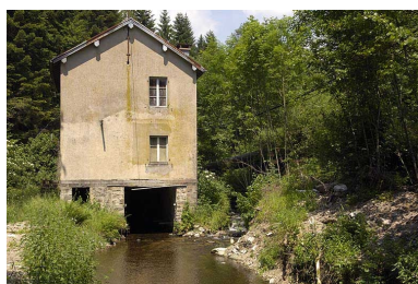
Vue depuis l'aval. Phot. Jérôme Mongreville IVR43_20057000345NUCA
