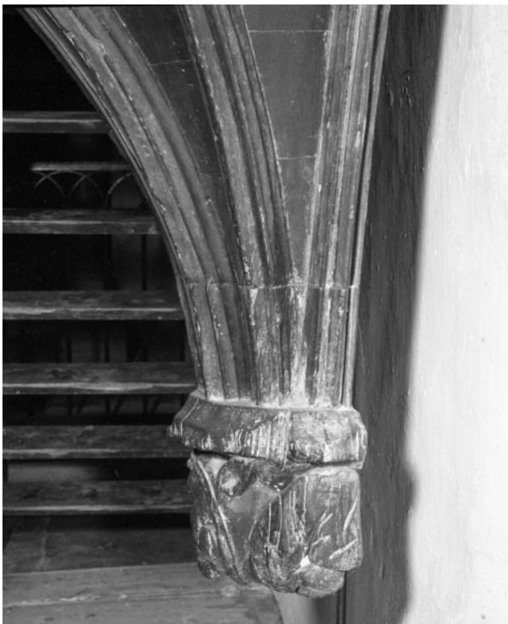
Détail de la cuve:culot
