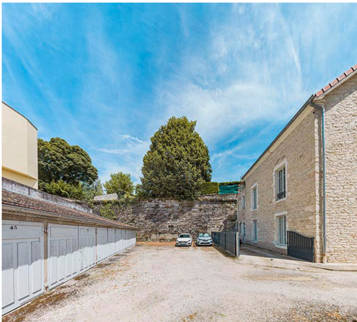
Portion du bastion Saint-Paul.
