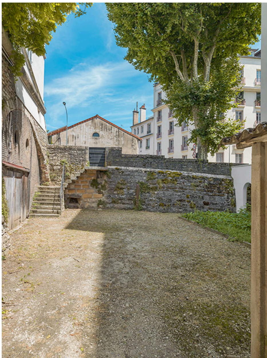
Raccord entre la courtine et le flanc sud du bastion Saint-Paul, rempart Saint-Pierre.
