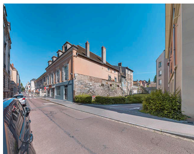
Portion du rempart et ancienne porte murée, rue de Thiard. Phot. Thierry Kuntz IVR26_20247100095NUC4A
