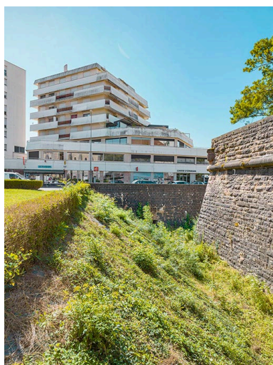
Le bastion Royal après restauration. Phot. Thierry Kuntz IVR26_20247100088NUC4A
