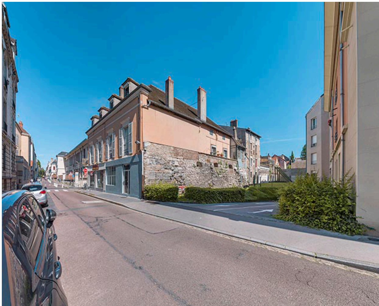
Portion du rempart et ancienne porte murée, rue de Thiard.
