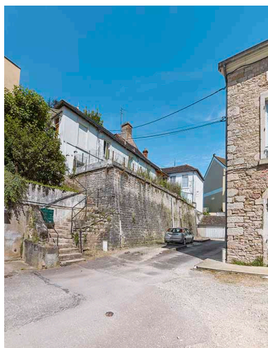
Casemate proche du bastion Saint-Paul. Phot. Thierry Kuntz IVR26_20247100050NUC4A
