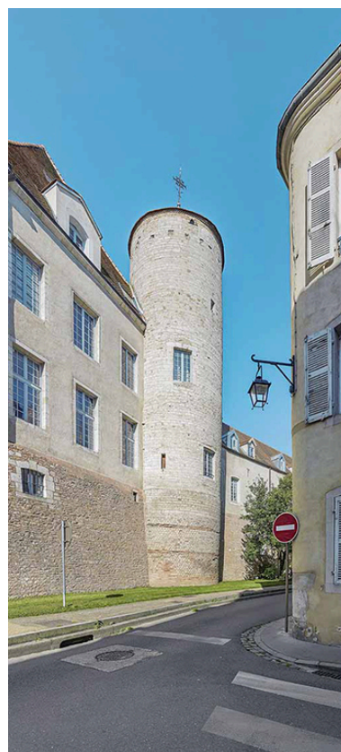
Tour de l'Evêché. Phot. Thierry Kuntz IVR26_20247100038NUC4A
