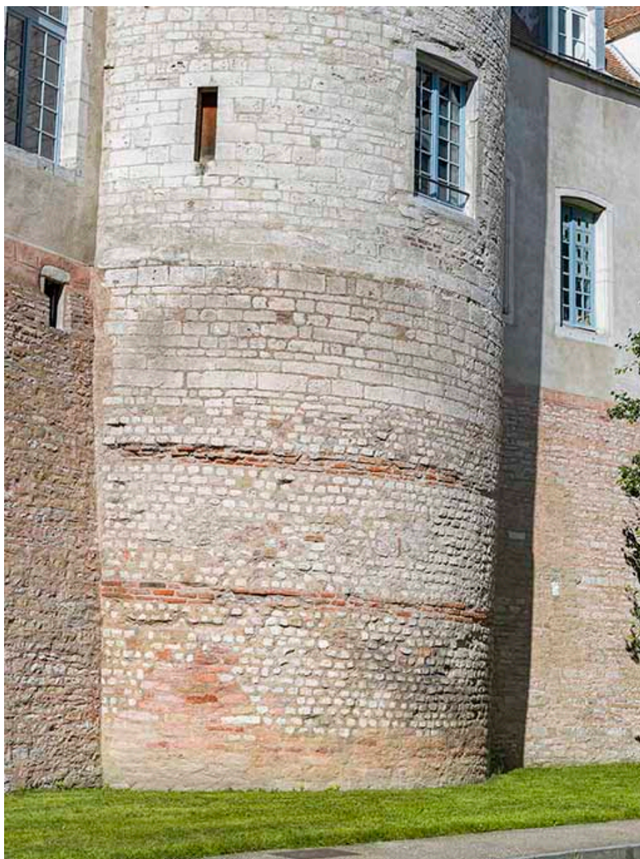
Détail de la maçonnerie, tour de l'Evêché.
