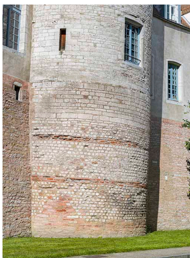
Détail de la maçonnerie, tour de l'Evêché. Phot. Thierry Kuntz IVR26_20247100041NUC4A
