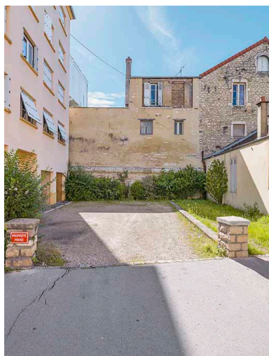
Mur d'une des faces du bastion Saint-Pierre, rue Professeur Leriche. Phot. Thierry Kuntz IVR26_20247100053NUC4A
