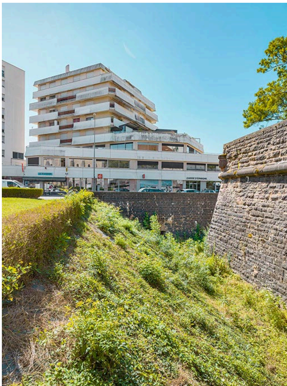
Le bastion Royal après restauration.
