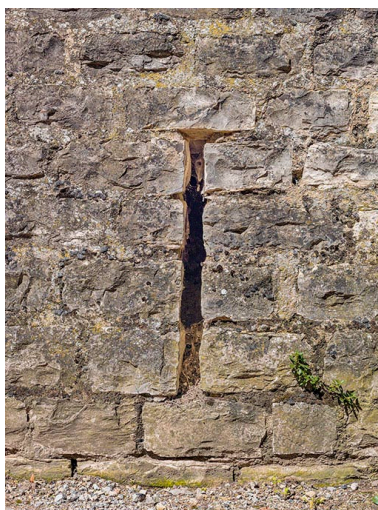
Une des embrasures de la casemate. Phot. Thierry Kuntz IVR26_20247100098NUC4A
