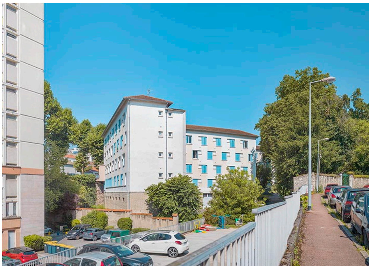
Immeubles construits dans l'ancien fossé aux remparts Saint-Vincent.
