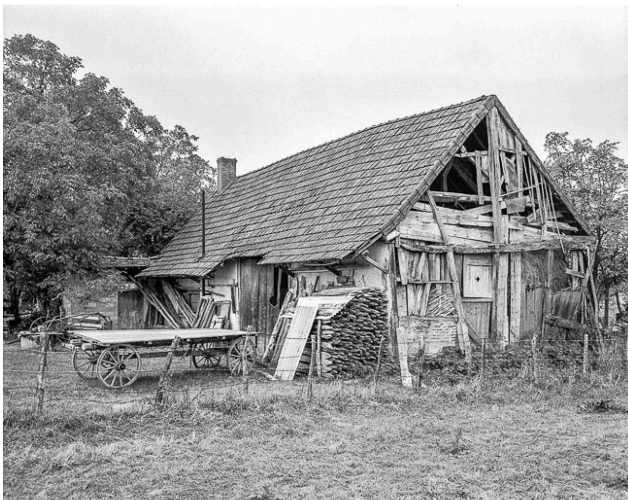
Façade antérieure et face droite.
