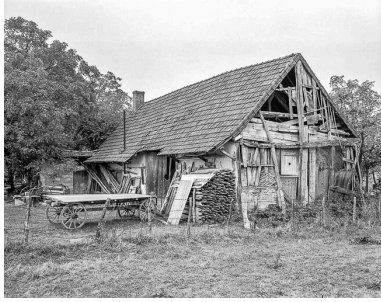
Façade antérieure et face droite.
