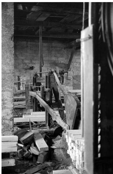
Scie à châssis horizontal, de profil. Phot. Laurent Poupard IVR43_19883900679Z
