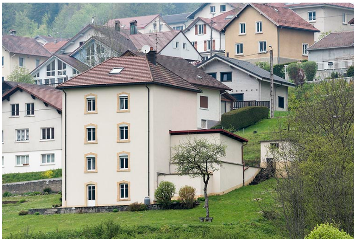
Façades postérieure et latérale gauche.
