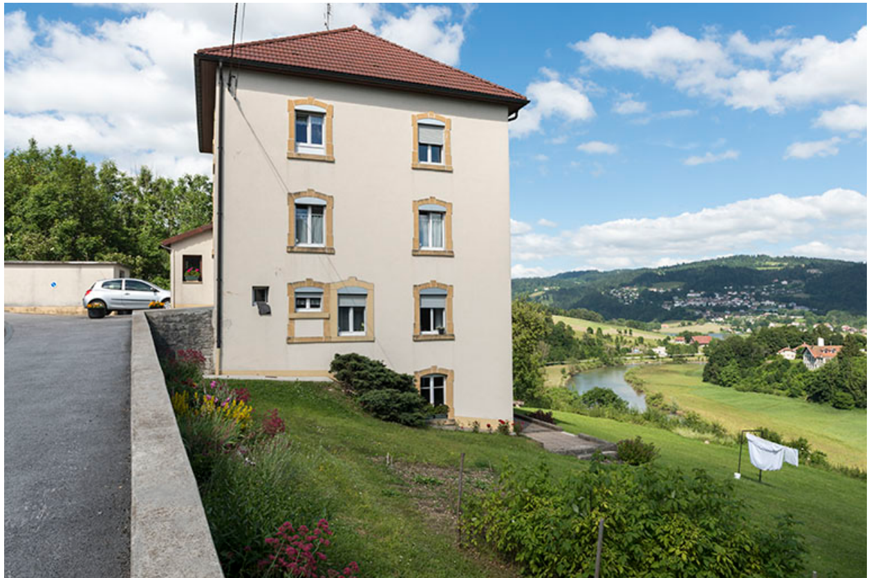
Façade latérale droite.
