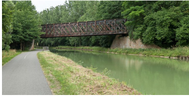
Vue d'ensemble du pont ferroviaire. Phot. Pierre-Marie Barbe-Richaud IVR26_20112103566NUC4AQ
