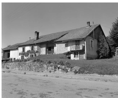
Fermes situées rue Saint-Martin. Phot. Yves Sancey IVR43_19802500939X
