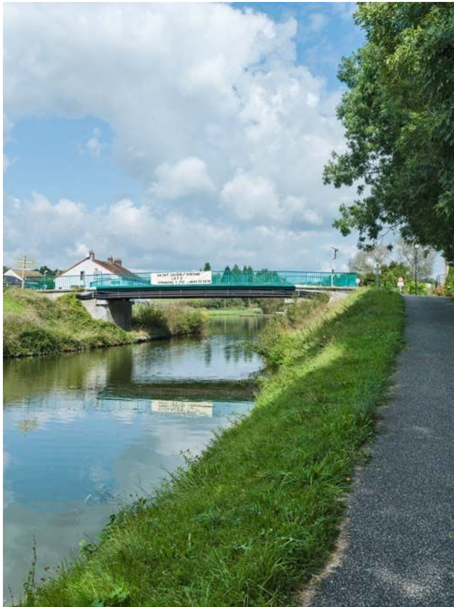
Vue d'ensemble du pont.
