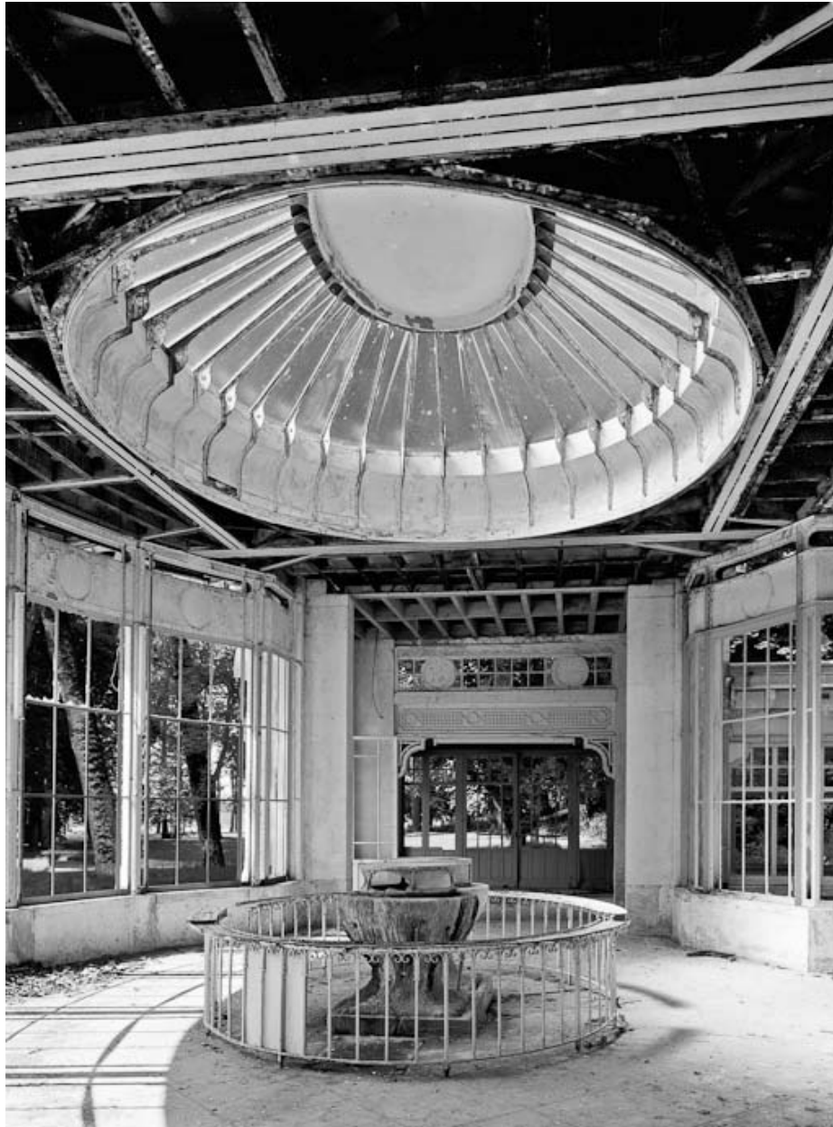
Vue de l'intérieur en direction du nord en 1984.
