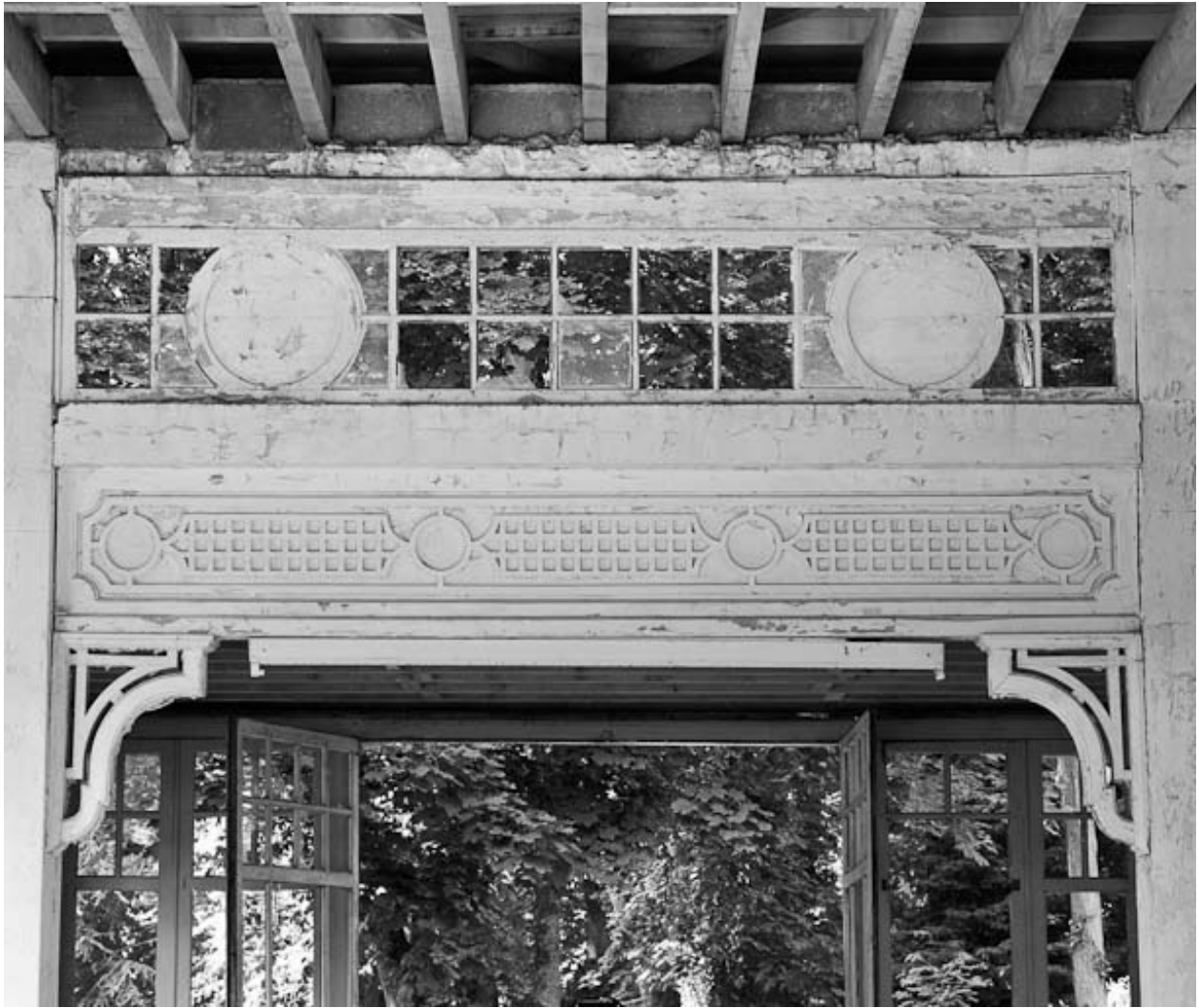
Détail du décor de la salle d'attente de la partie nord, vue en direction du nord en 1984.
