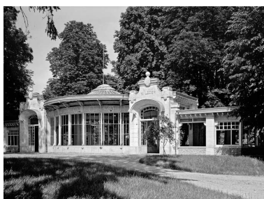
Façade ouest, vue en 1984. Phot. Jean-Luc Duthu IVR26_19845800050V
