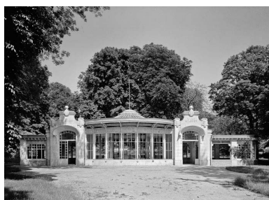
Façade ouest, vue en 1984. Phot. Jean-Luc Duthu IVR26_19845800049V
