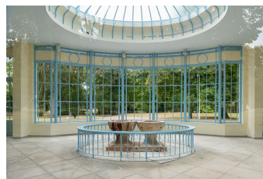
Vue de l'intérieur en direction de l'ouest en 2020. Phot. Pierre-Marie Barbe-Richaud IVR26_20205800598NUC4A
