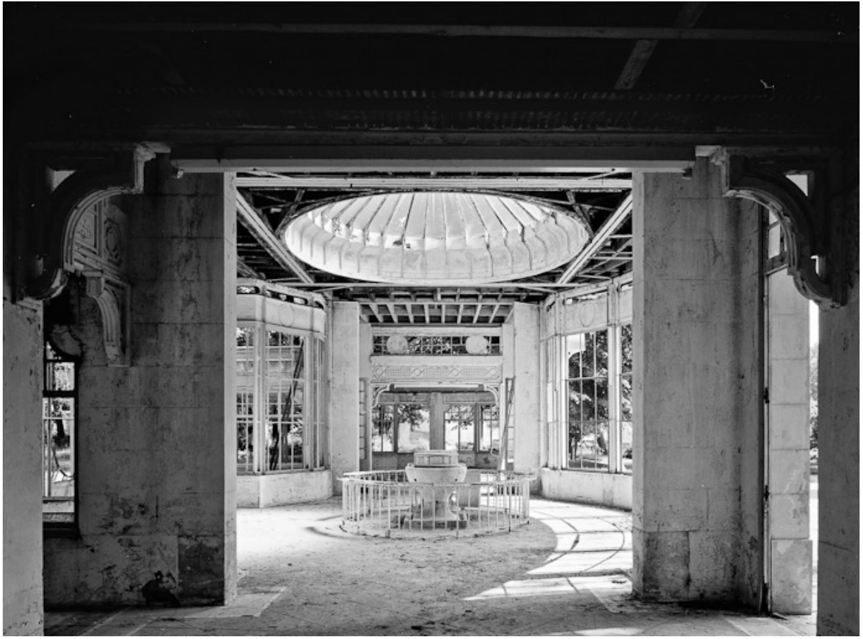
Vue de l'intérieur en direction du sud en 1984.
