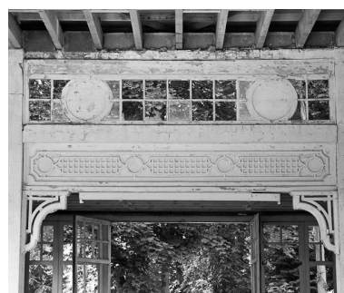
Détail du décor de la salle d'attente de la partie nord, vue en direction du nord en 1984. Phot. Michel Thierry IVR26_19845800056X
