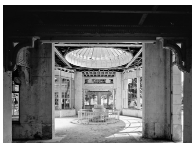
Vue de l'intérieur en direction du sud en 1984. Phot. Jean-Luc Duthu IVR26_19845800054V
