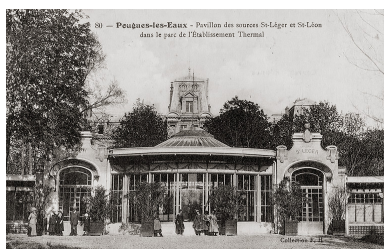
Façade ouest. Autr. auteur inconnu IVR26_20195800755NUC4A
