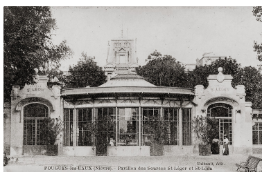
Façade ouest. Autr. auteur inconnu IVR26_20195800756NUC4A
