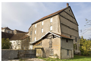
Elévation de l'atelier de minoterie. Phot. Jérôme Mongreville IVR43_20077000579NUCA
