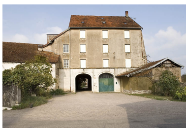
Façade antérieure vue de face. Phot. Jérôme Mongreville IVR43_20077000576NUCA
