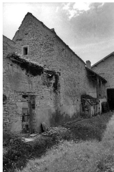
Entrée de la cour. Phot. Bernard Lardière IVR43_19817000535Z
