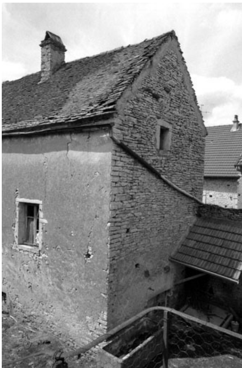
Habitation sur cave : bâtiment sur cour.
