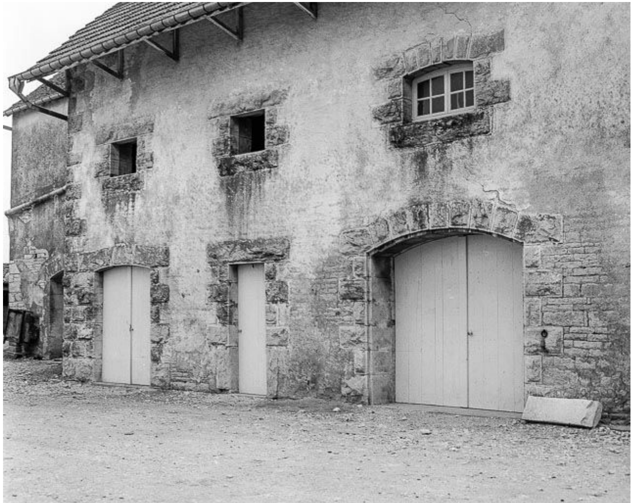
Partie agricole : détail de la façade postérieure.
