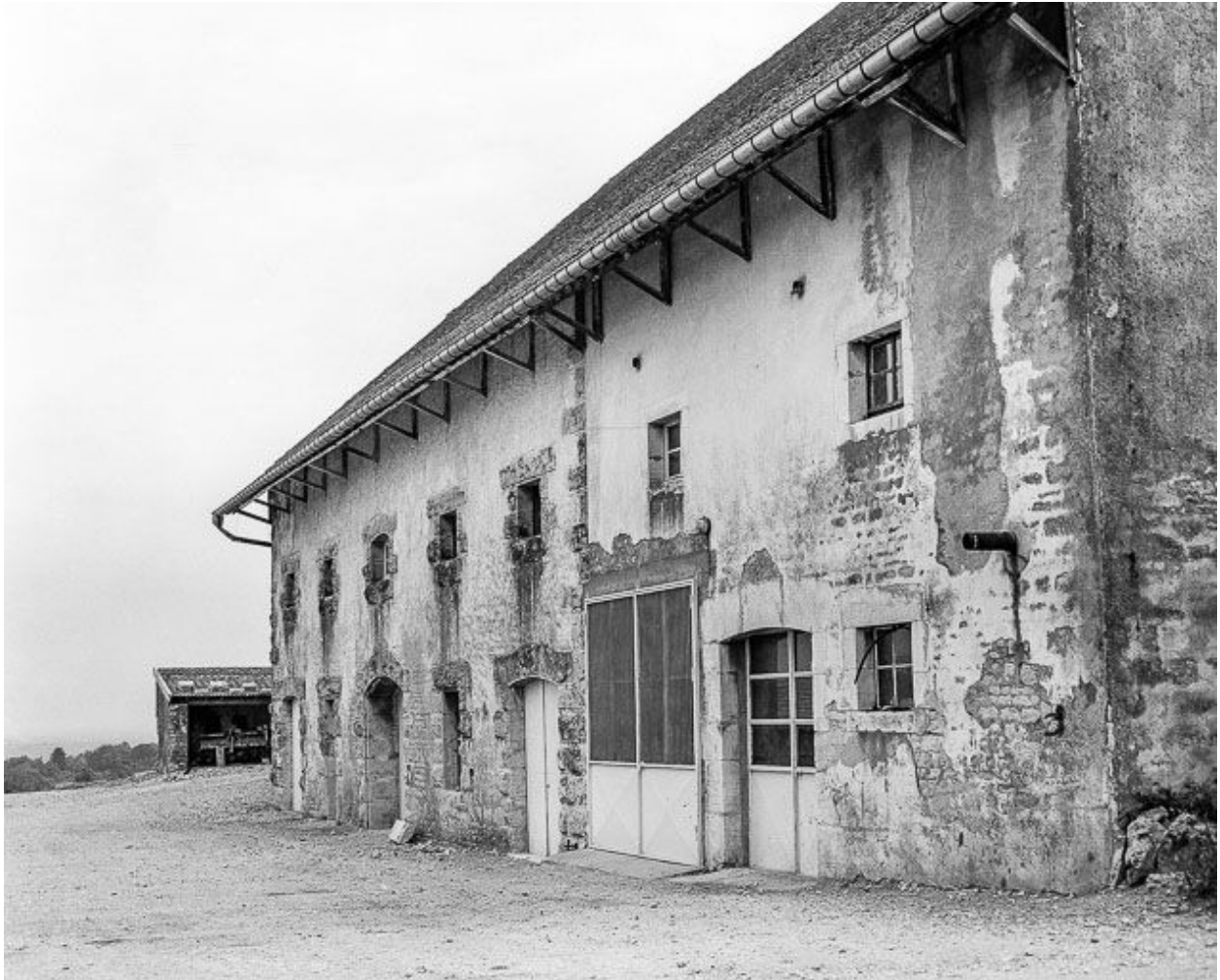
Partie agricole : façade postérieure.
