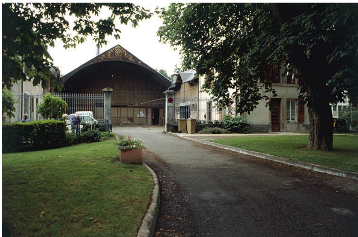
Les écuries depuis le nord.
