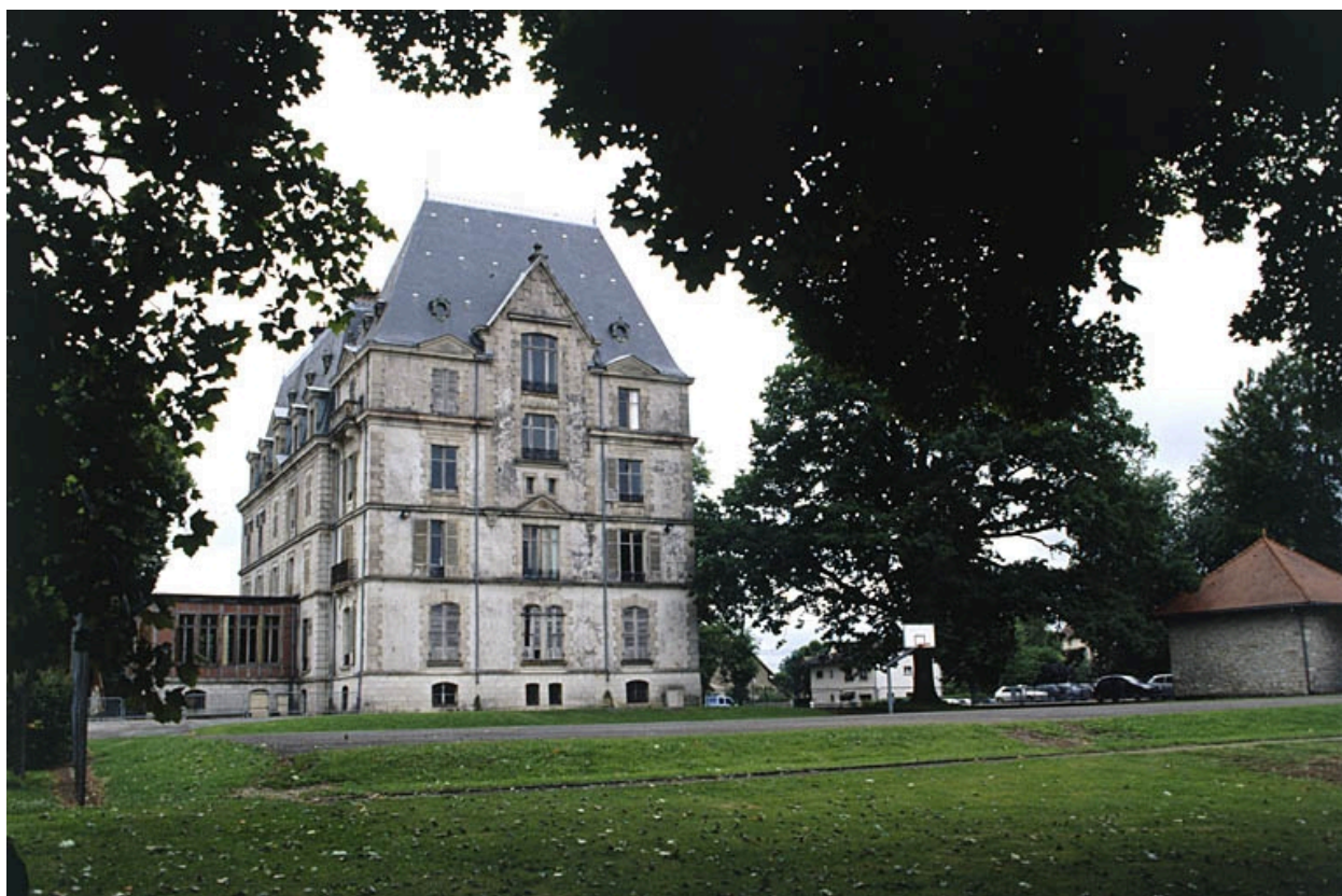
Façade ouest vue de trois quarts gauche.
