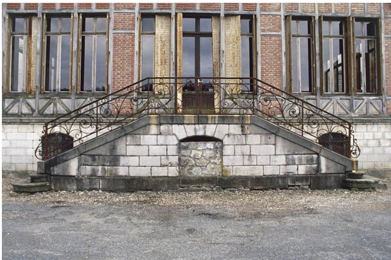
Escalier sur la façade postérieure.
