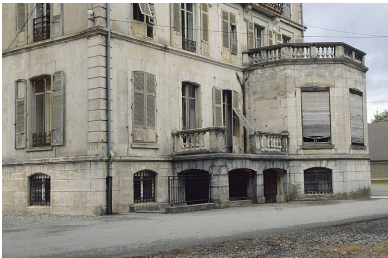
Détail de la façade est.
