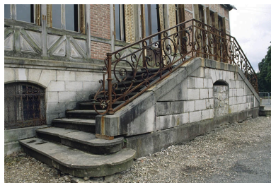
Détail de l'escalier de la façade postérieure. Phot. Yves Sancey IVR43_20009000452ZA
