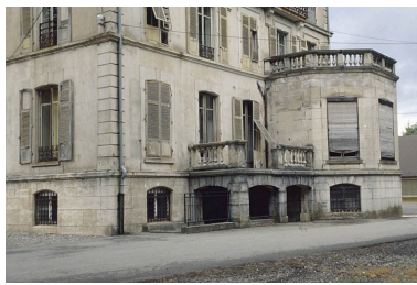
Détail de la façade est. Phot. Yves Sancey IVR43_20009000448ZA
