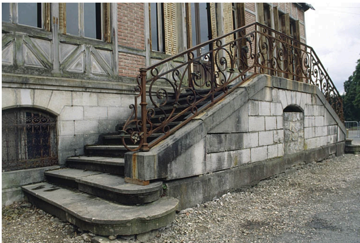
Détail de l'escalier de la façade postérieure.
