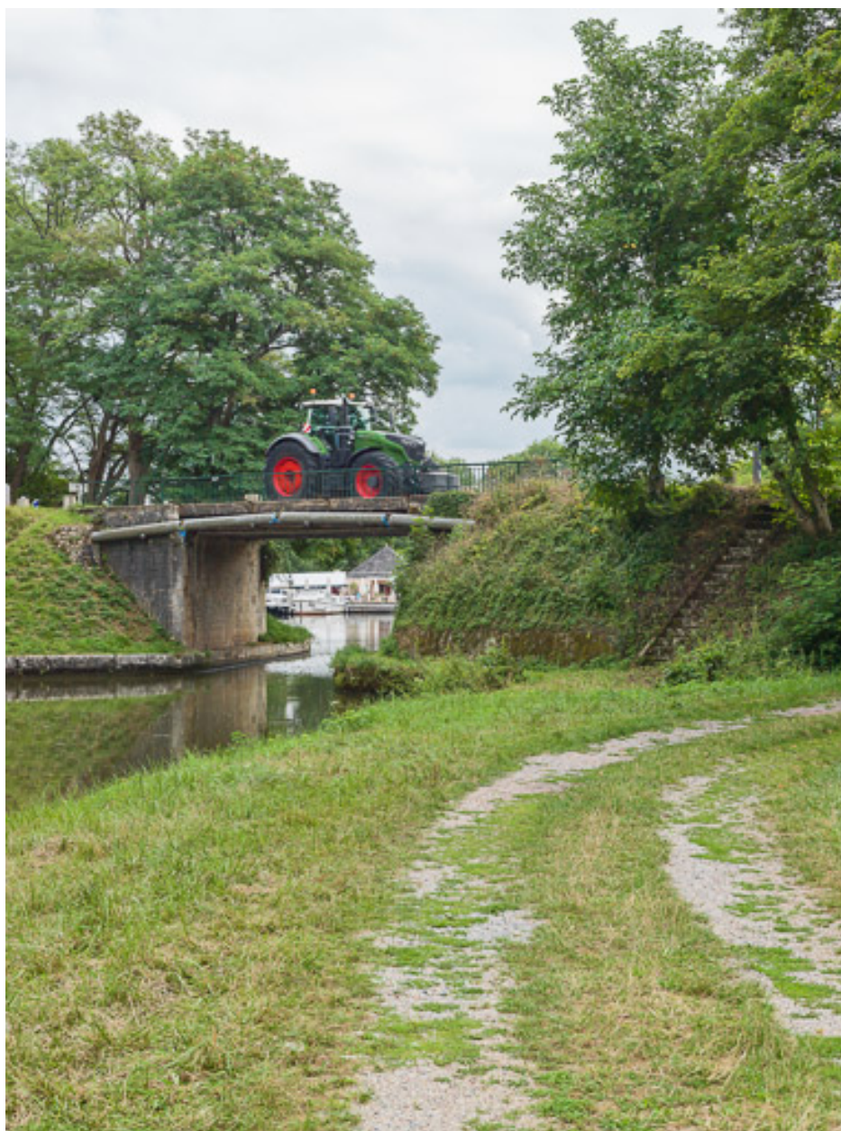
Vue d'ensemble du pont.
