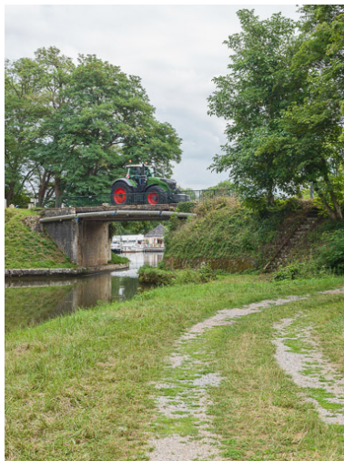
Vue d'ensemble du pont.
