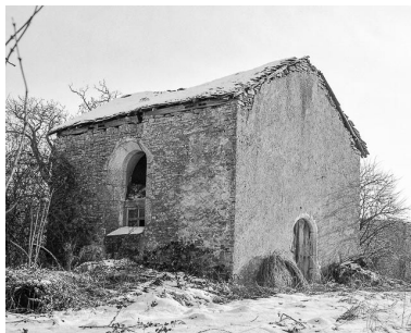
Vue d'ensemble. Phot. Bernard Lardière IVR43_19817000028X
