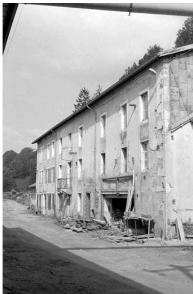
Ancien atelier de fabrication.
