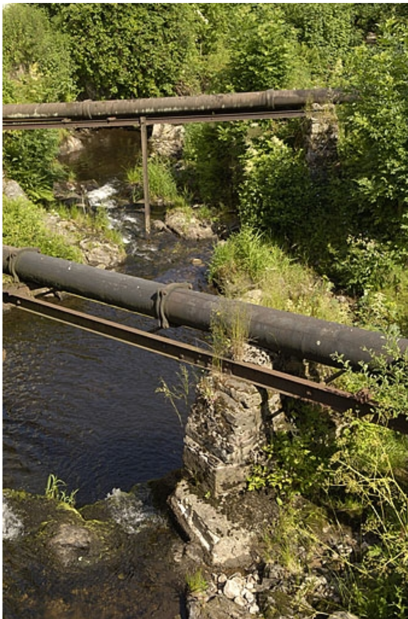
Conduites forcées enjambant le Breuchin.
