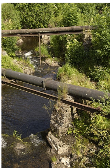
Conduites forcées enjambant le Breuchin. Phot. Jérôme Mongreville IVR43_20057000281NUCA
