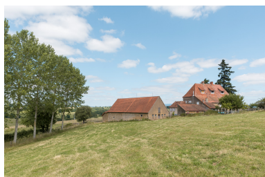
Vue d'ensemble depuis le sud-ouest. Phot. Pierre-Marie Barbe-Richaud IVR26_20187100329NUC4A
