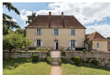
Façade antérieure du logement Phot. Pierre-Marie Barbe-Richaud IVR26_20187100310NUC4A
