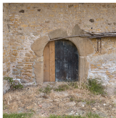
Façade antérieure du bâtiment agricole. Porte cintrée d'une étable. Phot. Pierre-Marie Barbe-Richaud IVR26_20187100317NUC4A
