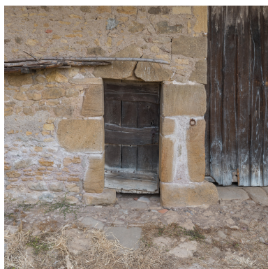
Façade antérieure du bâtiment agricole. Porte piétonne. Phot. Pierre-Marie Barbe-Richaud IVR26_20187100318NUC4A
