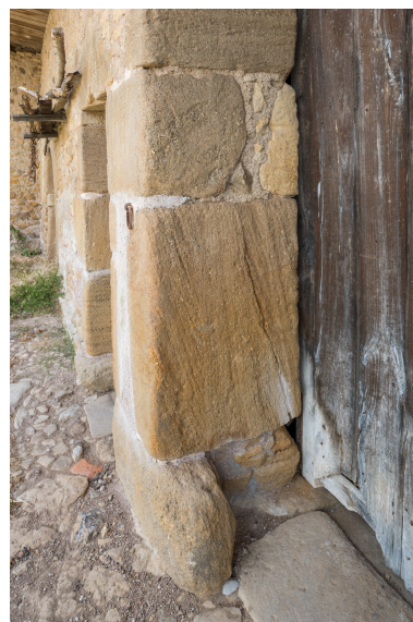
Bâtiment agricole. Piédroit de la porte de remise. Phot. Pierre-Marie Barbe-Richaud IVR26_20187100320NUC4A
