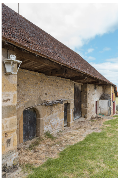
Vue de trois quarts gauche du bâtiment agricole. Phot. Pierre-Marie Barbe-Richaud IVR26_20187100316NUC4A
