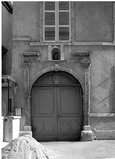
Détail du portail d'entrée.
