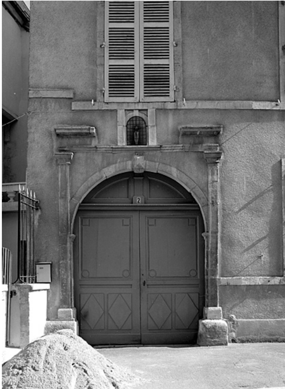
Détail du portail d'entrée.
