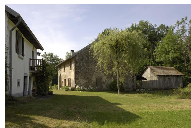
Logement, moulin et huilerie depuis le nord. Phot. Jérôme Mongreville IVR43_20057000280NUCA
