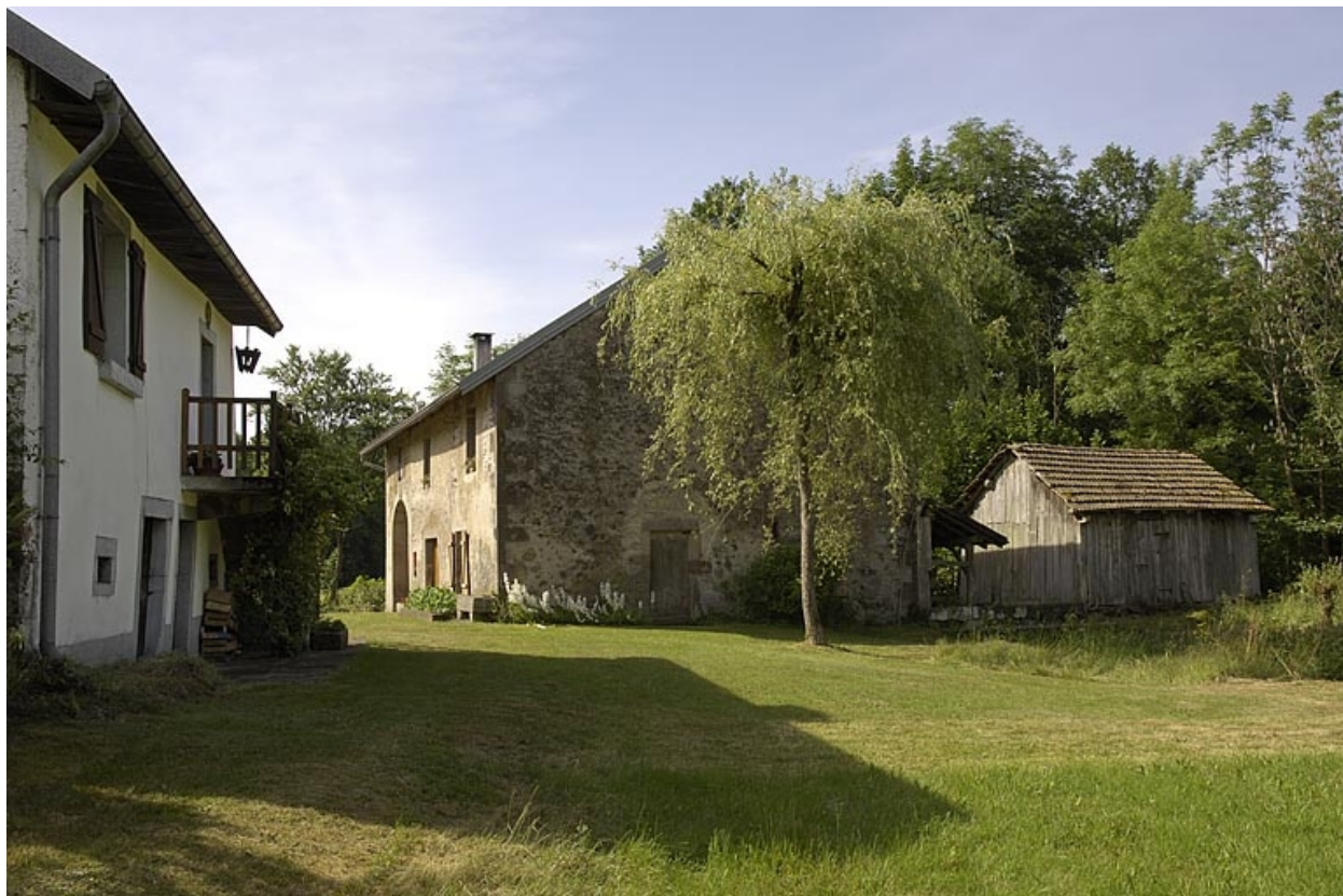
Logement, moulin et huilerie depuis le nord.
