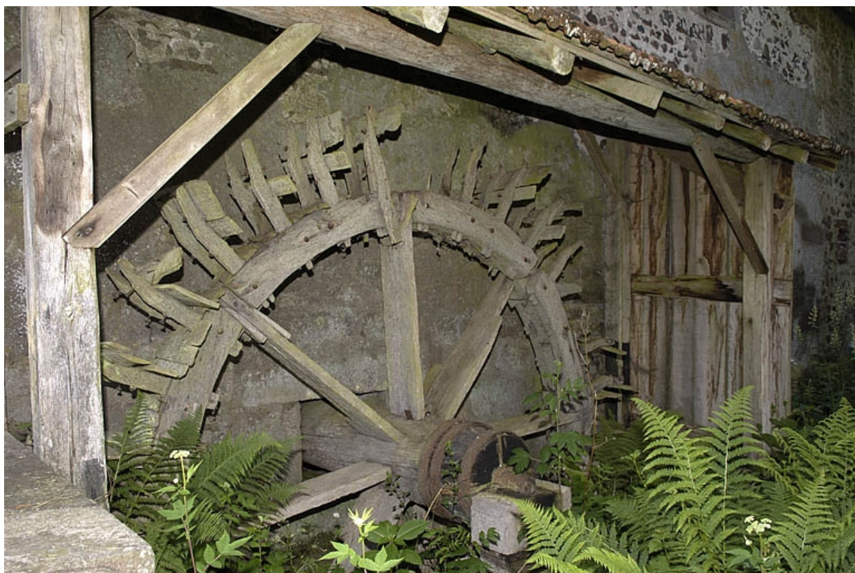
Détail de la roue hydraulique en dessous.
