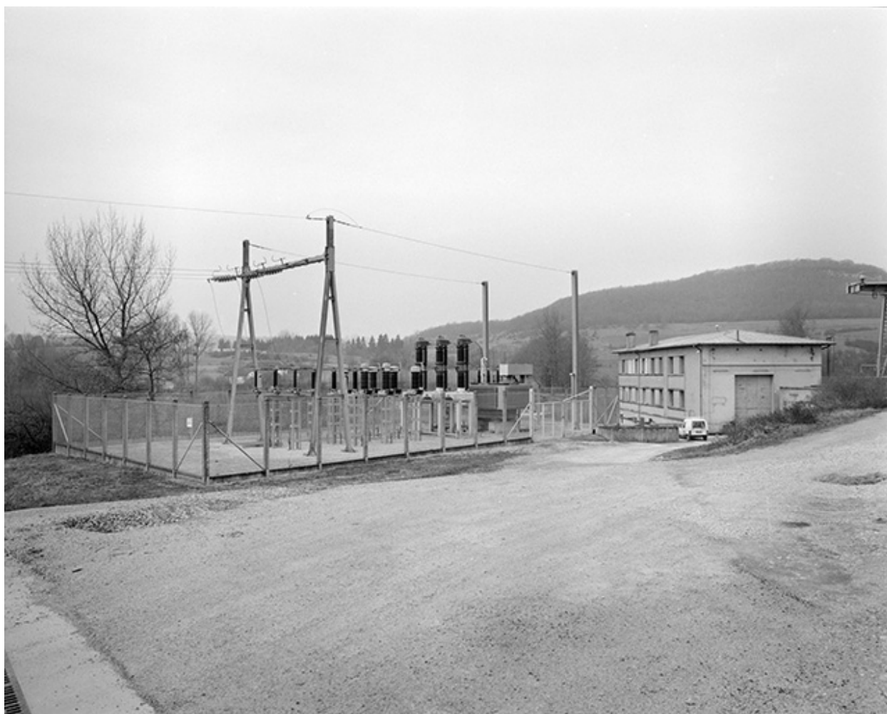
Transformateur et salle des machines.
