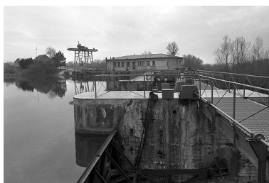
Vue d'ensemble depuis le nord-ouest. De gauche à droite : logement, pont roulant, salle des machines, barrage et vannes-secteur au premier plan. Phot. Jérôme Mongreville IVR43_19963900135X
