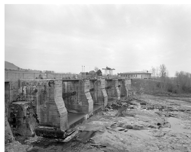
Barrage et vannes-secteurs. Phot. Jérôme Mongreville IVR43_19963900139X
