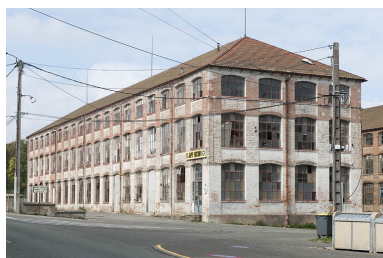
Vue d'ensemble rapprochée depuis le sud-est.
