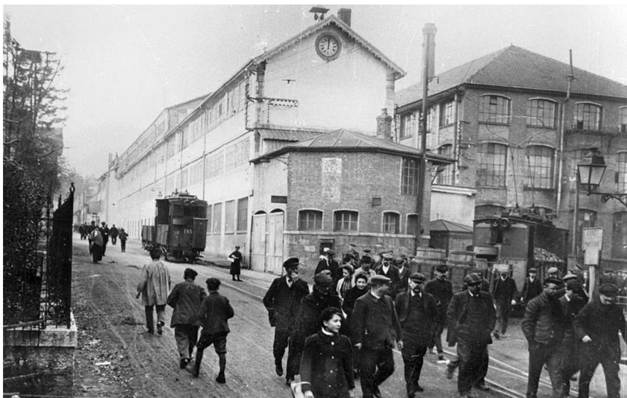
L'usine des Fonteneilles.
