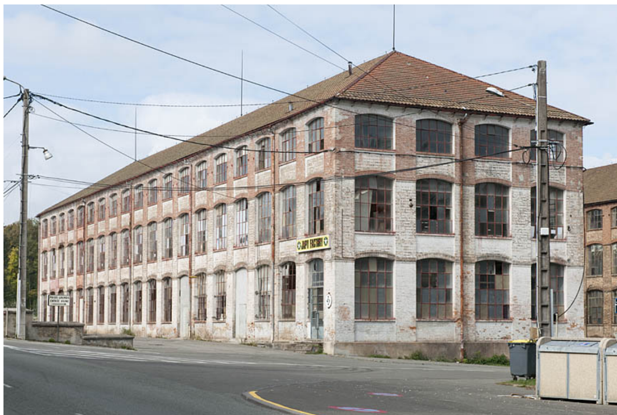
Vue d'ensemble rapprochée depuis le sud-est.
