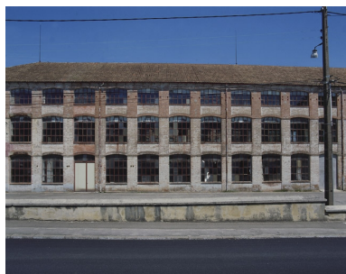
Travées de la façade sud.
