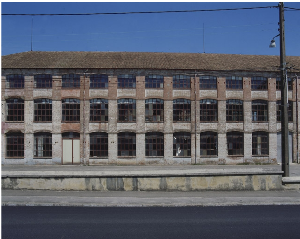
Travées de la façade sud.
