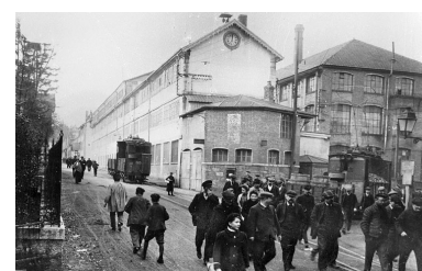
L'usine des Fonteneilles. Phot. Jérôme Mongreville IVR43_20019000193X
