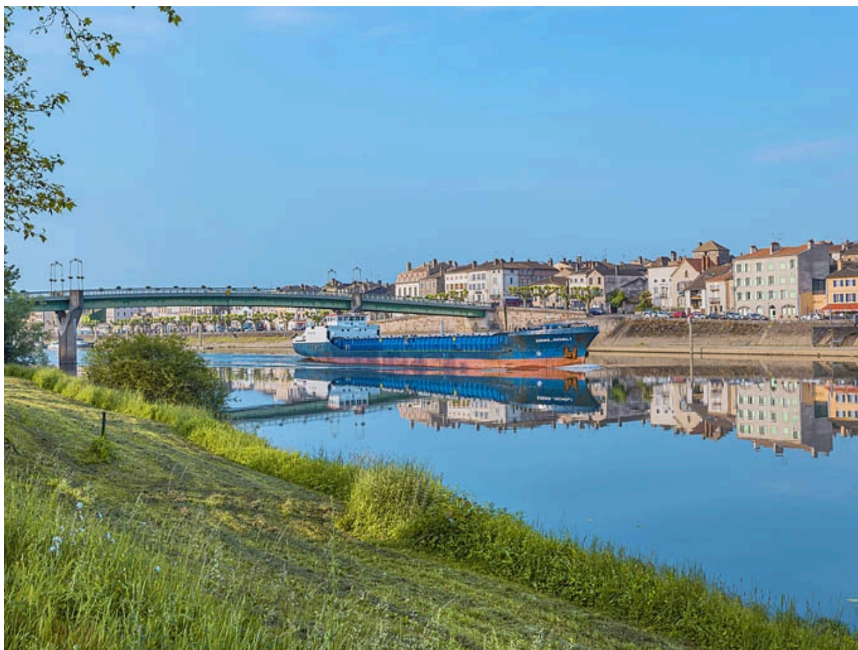
Le pont de Tournus, vu d'amont, depuis la rive gauche.
