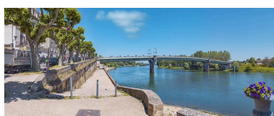
Le pont de Tournus, vu d'aval, au niveau de la banquette de halage. Phot. Thierry Kuntz IVR26_20217100457NUC4A
