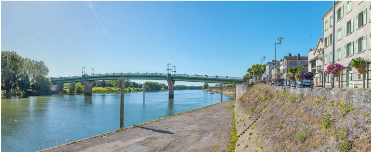
Le pont de Tournus, vu d'amont, rive droite.
