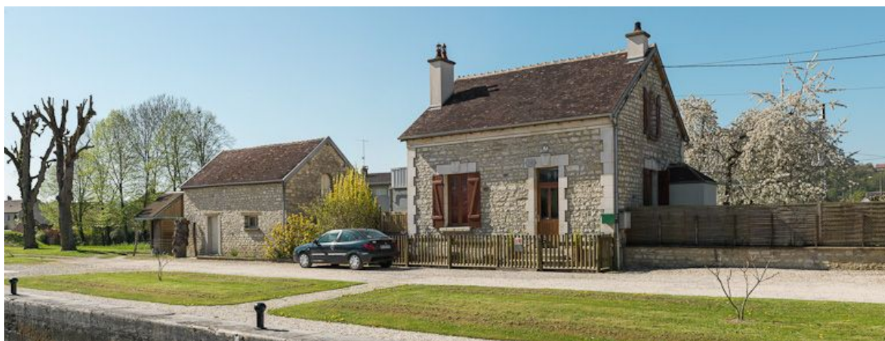
Vue d'ensemble de la maison éclusière.
