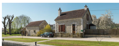
Vue d'ensemble de la maison éclusière.
