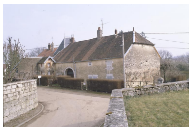
Ferme située rue de Lieucourt. Phot. Yves Sancey IVR43_19857000096XA
