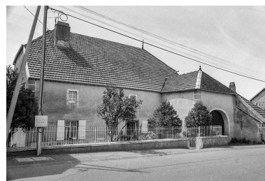
Ferme située rue Haute. Phot. Bernard Lardière IVR43_19817000447Z
