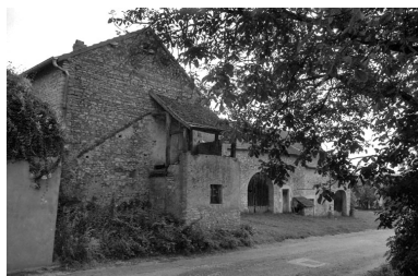
Ferme située rue Basse de l'Eglise. Phot. Bernard Lardière IVR43_19817000619Z
