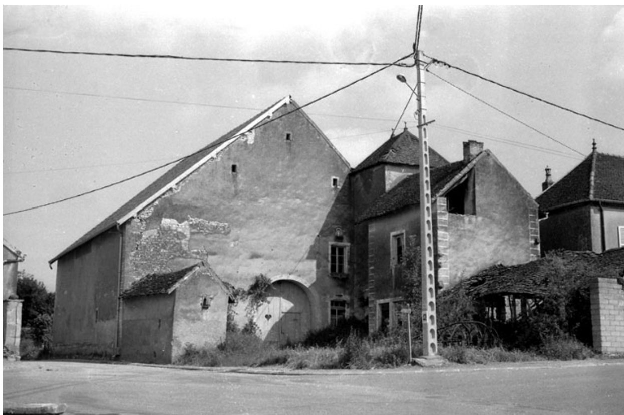
Ferme située place de l'Eglise
