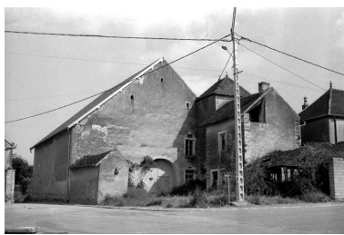
Ferme située place de l'Eglise Phot. Bernard Lardière IVR43_19817000613Z
