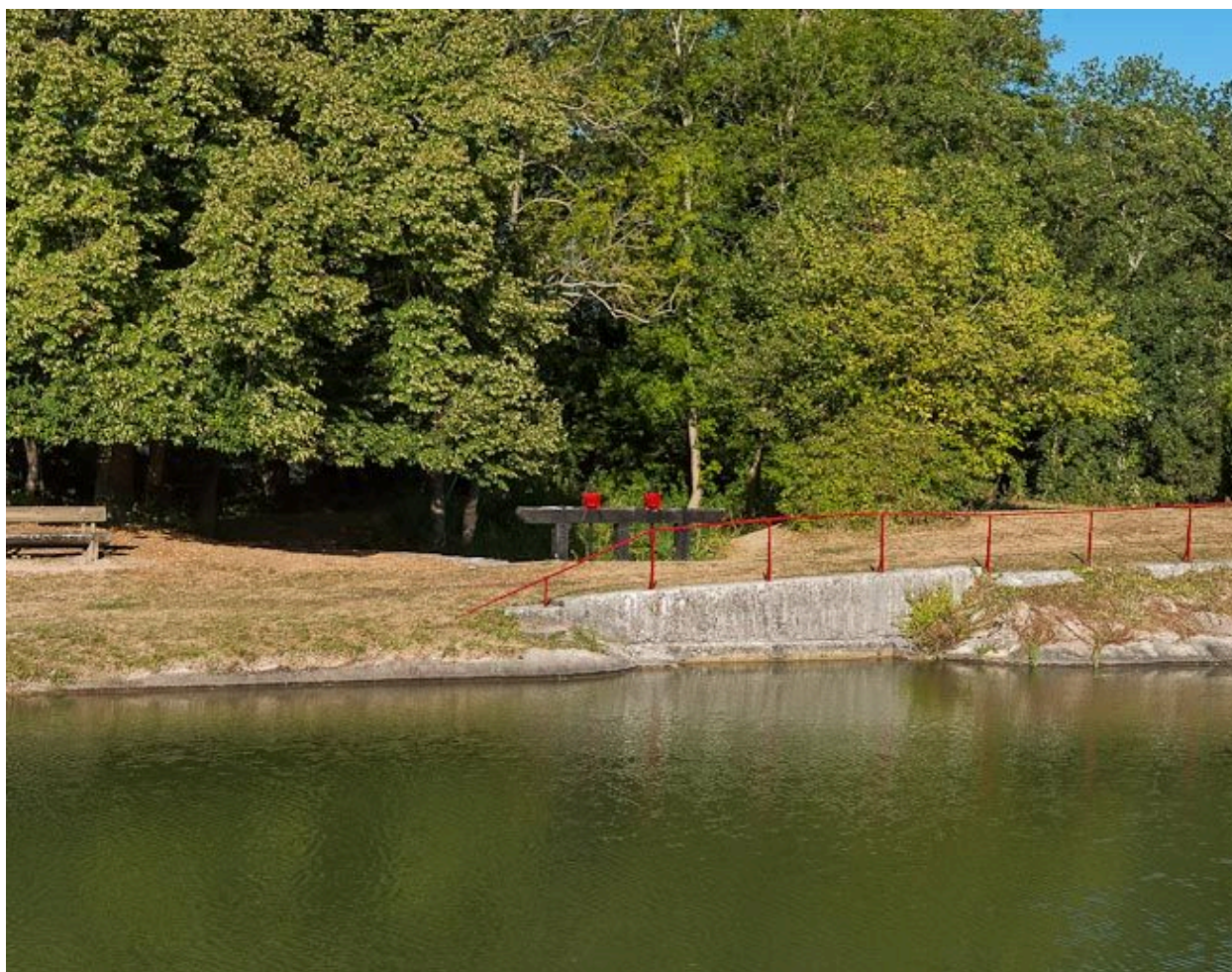
Arrivée d'eau avec les deux vannes.
