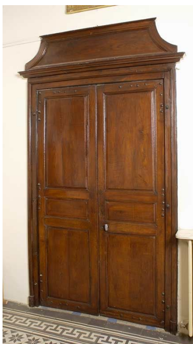
Chapelle : détail d'une porte. Phot. Michel Thierry IVR26_20047101112NUC2A
