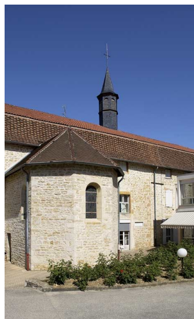
Façade postérieure. Phot. Michel Thierry IVR26_20047101072NUC2A
