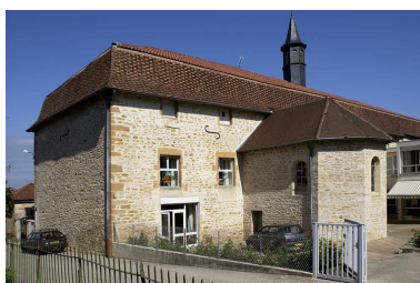
Façade postérieure. Phot. Michel Thierry IVR26_20047101073NUC2A
