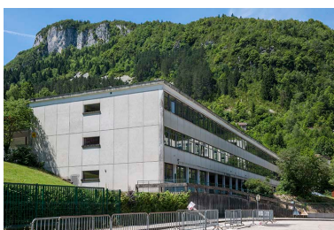
Externat : façade postérieure. Phot. Jérôme Mongreville IVR43_20143900439NUC4A
