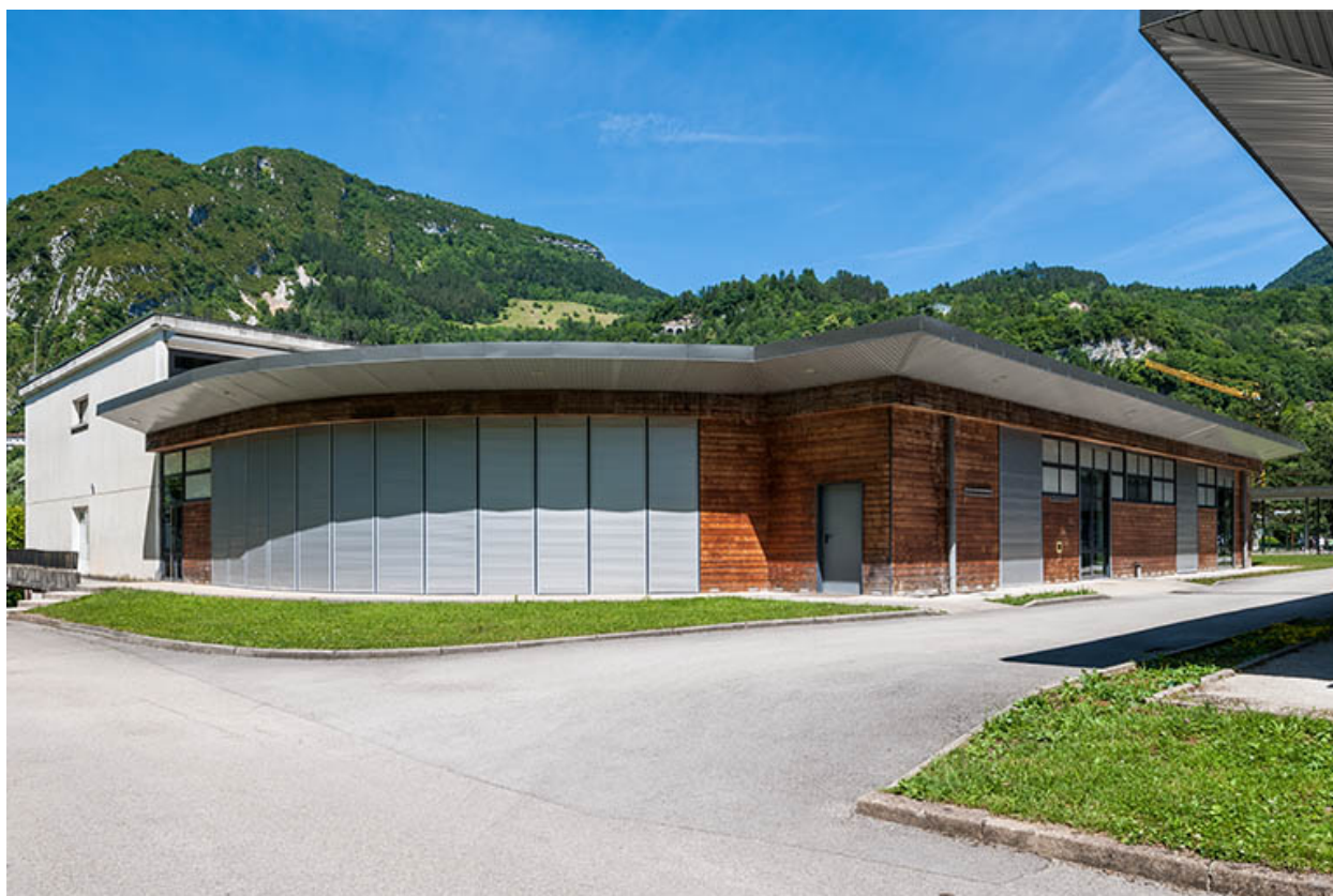
Extension de l'externat : façades.
