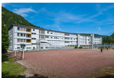
Internat : façade Est, terrain de football. Phot. Jérôme Mongreville IVR43_20143900450NUC4A
