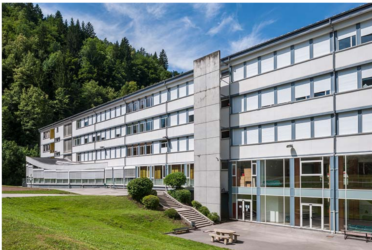
Internat : façade antérieure rénovée et aménagements extérieurs.
