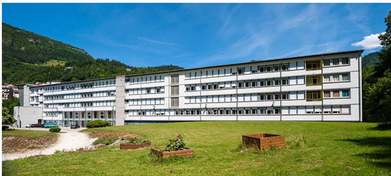
Internat : façade postérieure, vue générale.
