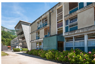
Administration : vue depuis le côté est avec au second plan l'extension de l'internat. Phot. Jérôme Mongreville IVR43_20143900421NUC4A
