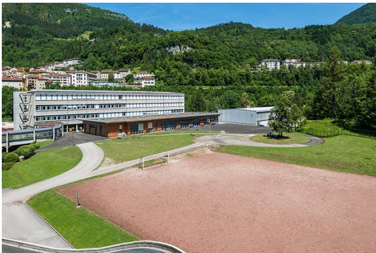
Externat : vue d'ensemble.
