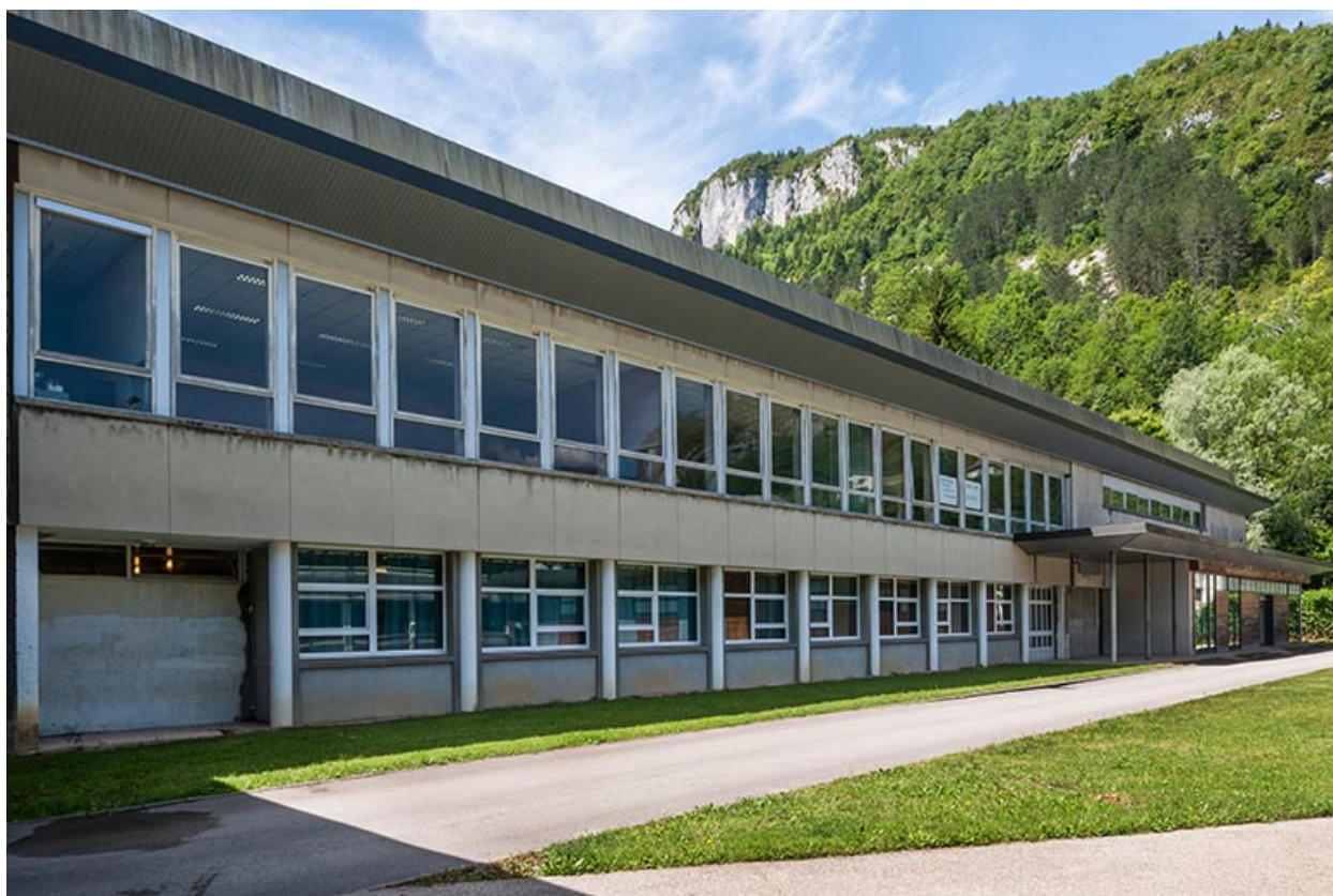
Atelier : façade est.
