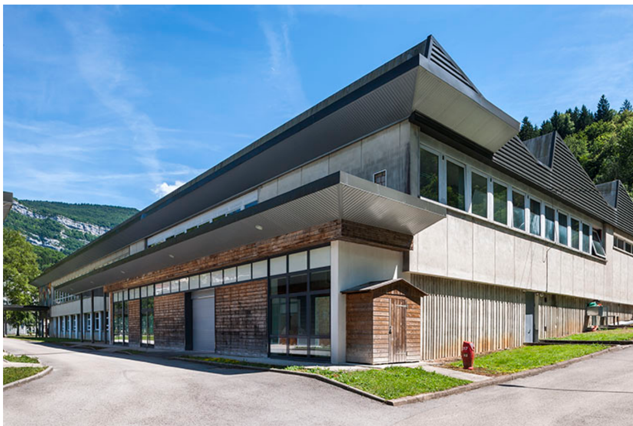
Atelier : vue d'ensemble.
