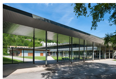
Passage couvert reliant l'atelier à l'externat tertiaire. Phot. Jérôme Mongreville IVR43_20143900437NUC4A
