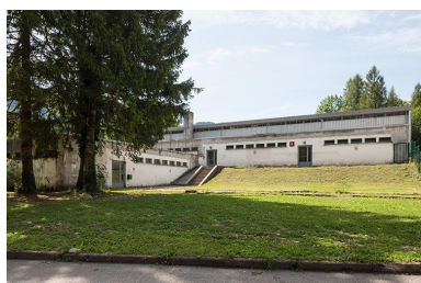
Externat : vue postérieure. Phot. Jérôme Mongreville IVR43_20143900447NUC4A
