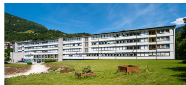
Internat : façade postérieure, vue générale. Phot. Jérôme Mongreville IVR43_20143900456NUC4A
