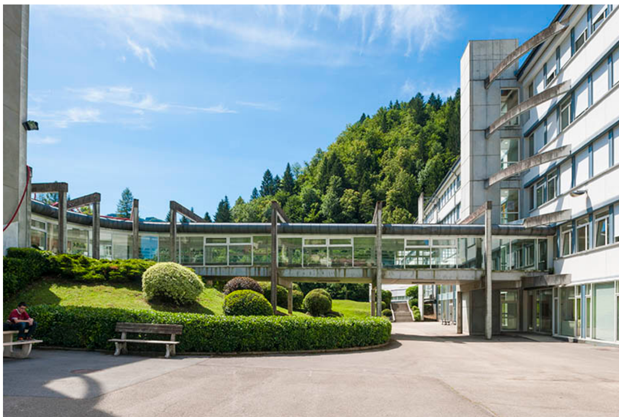
Passerelle couverte entre internat et externat.
