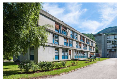
Administration : façade postérieure. Phot. Jérôme Mongreville IVR43_20143900419NUC4A
