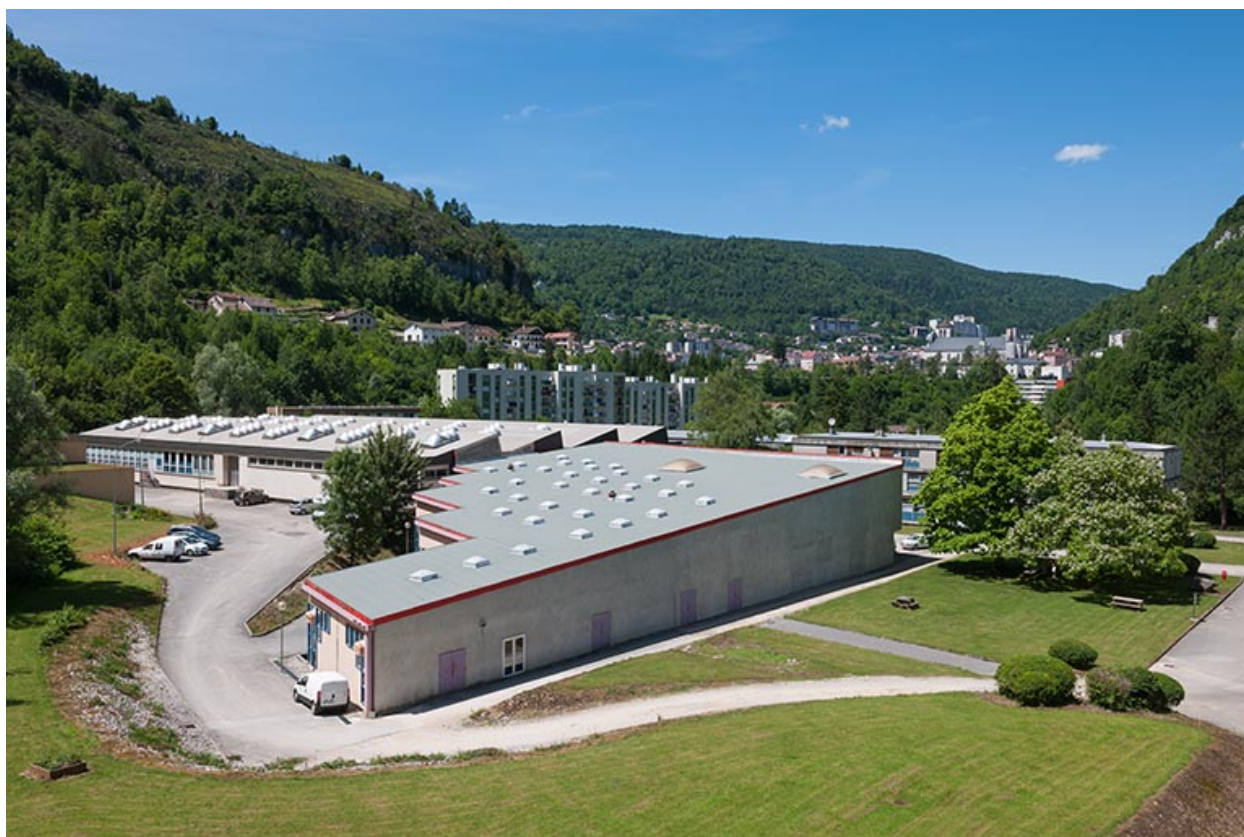
Ateliers : vue d'ensemble des toitures.
