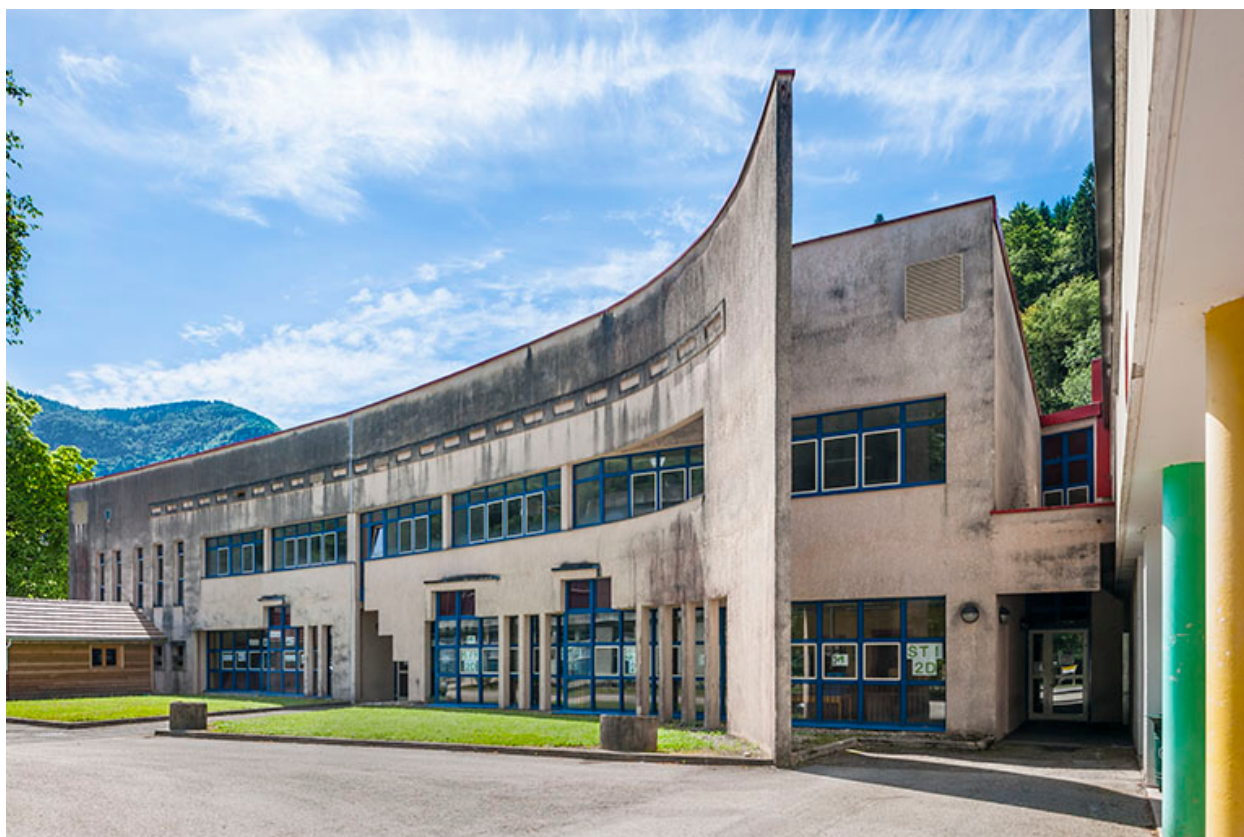
Façade antérieure de l'ancien atelier mécanique.
