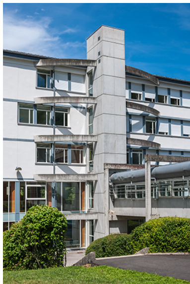
Internat : détail de la façade antérieure. Phot. Jérôme Mongreville IVR43_20143900452NUC4A
