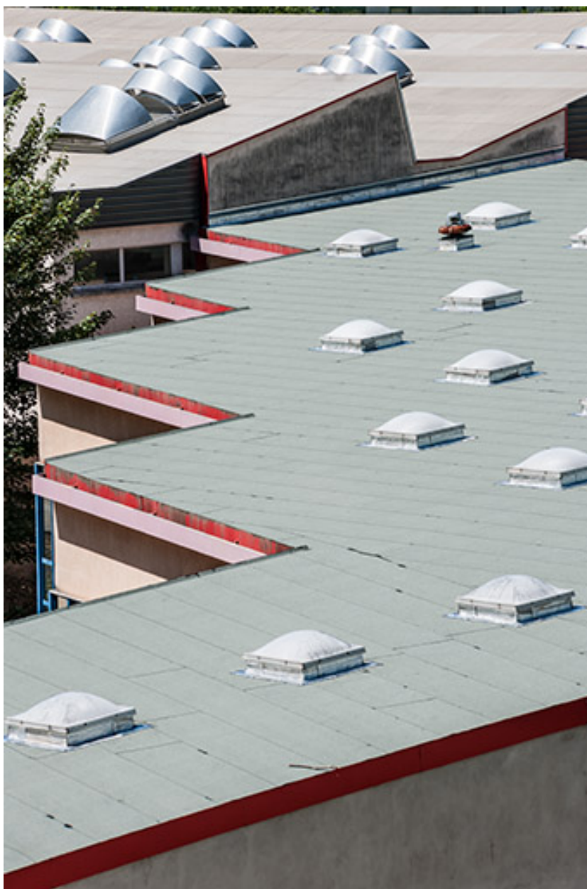
Toitures des deux ateliers : détail.
