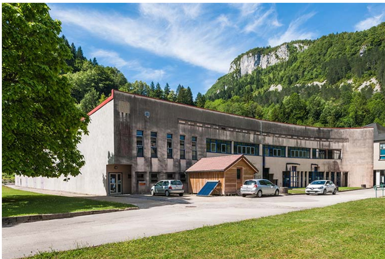
Atelier, ancien atelier mécanique : vue d'ensemble.
