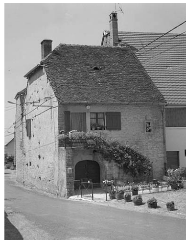
Maison de vigneron située rue du Meix Dagay : vue d'ensemble. Phot. Dominique Dominguez IVR43_19803900237X
