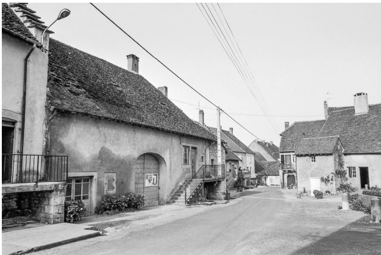
Vue générale de la rue principale.
