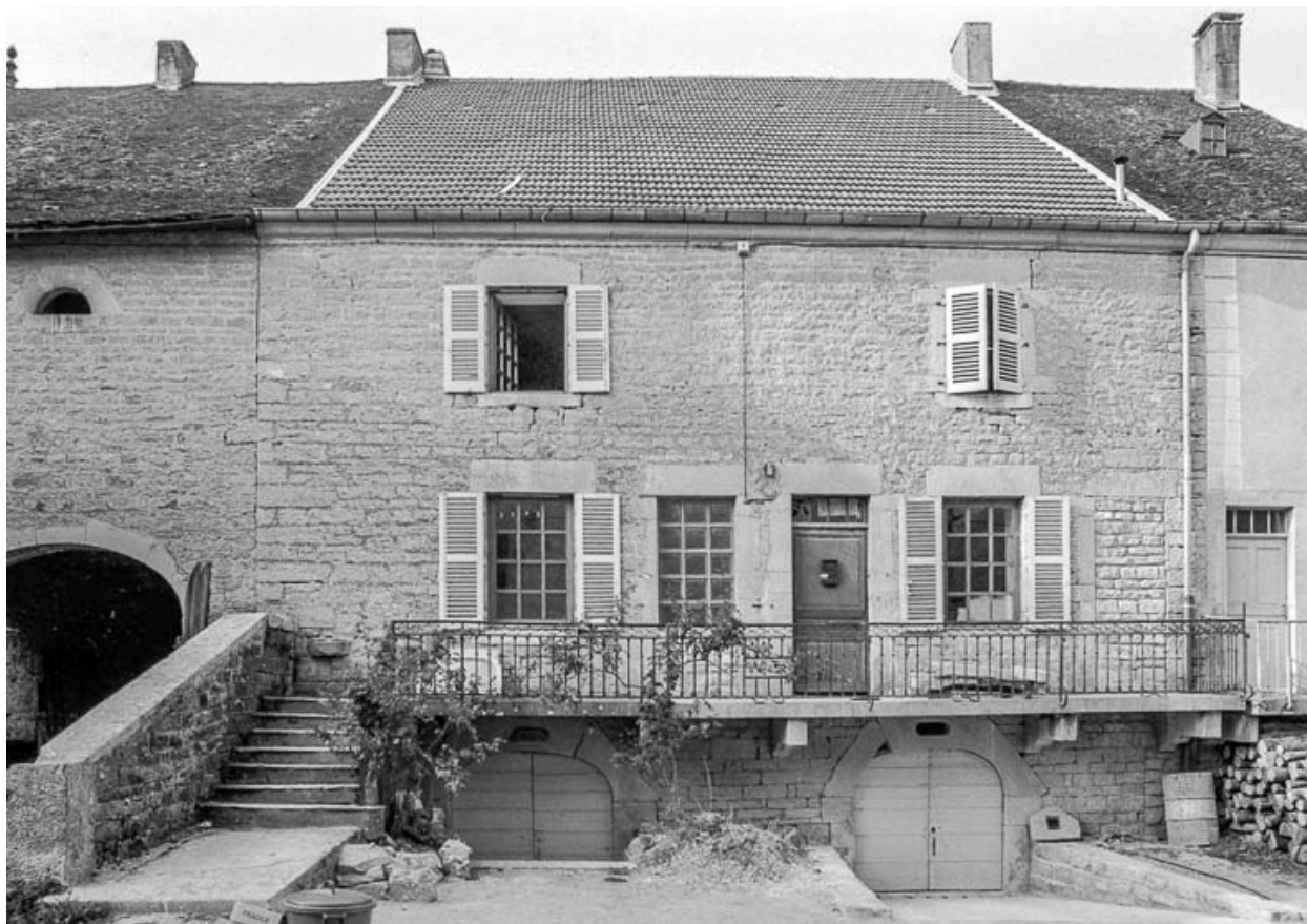
Maison de vigneron (?) cadastrée AD 325 : façade antérieure.
