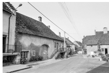
Vue générale de la rue principale. Phot. Bernard Pontefract IVR43_19763900308Z
