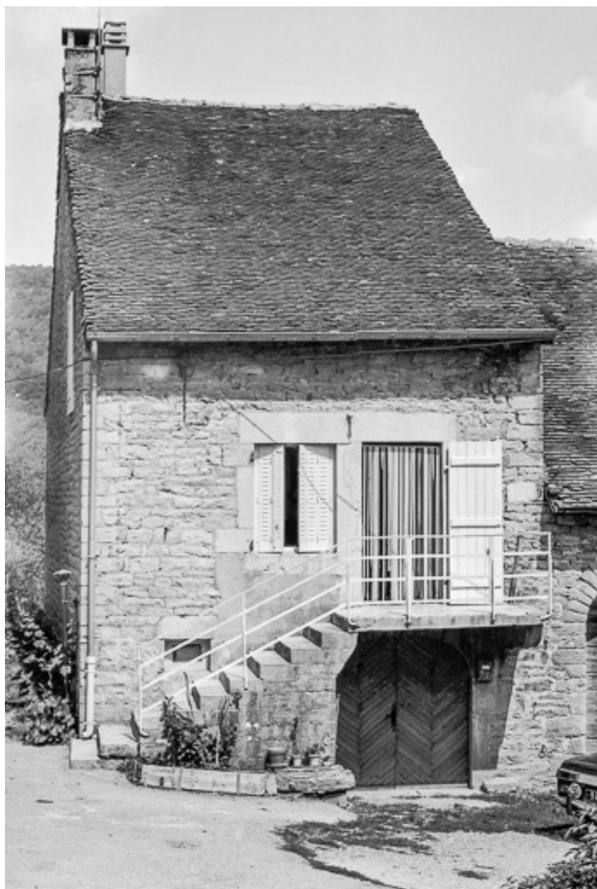
Maison de vigneron située chemin de Cluzon : façade antérieure.
