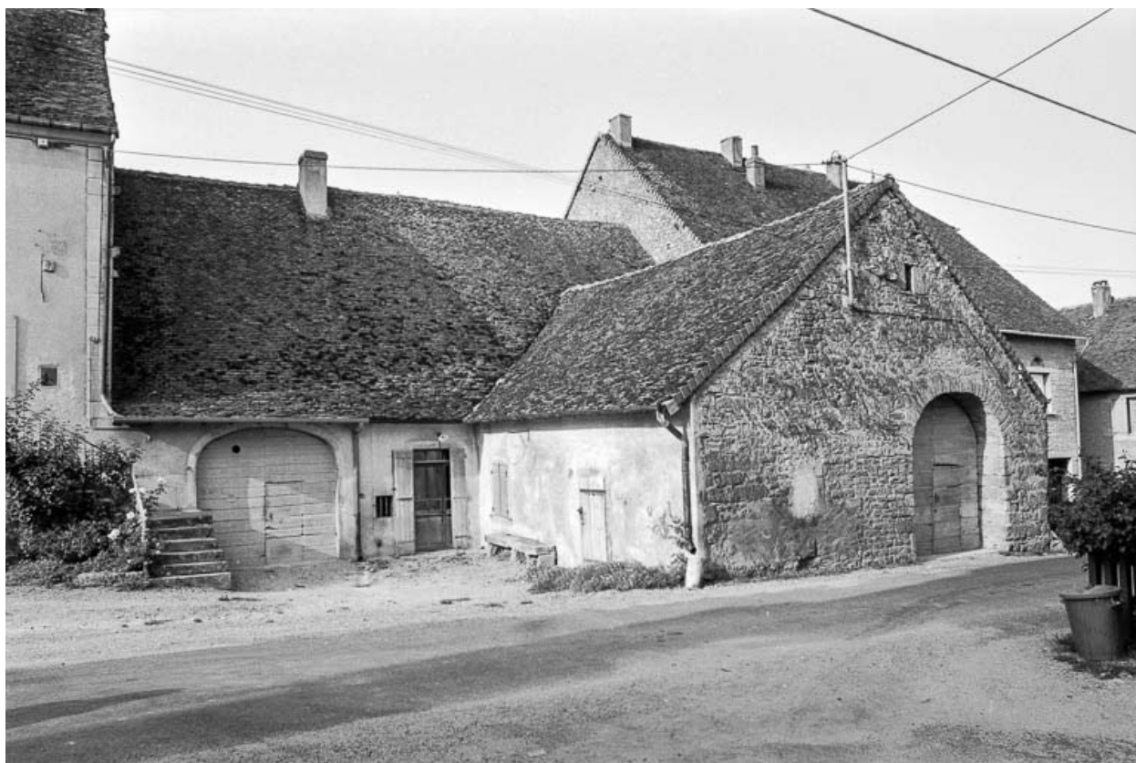
Ferme cadastrée AD 327 : façades antérieures.
