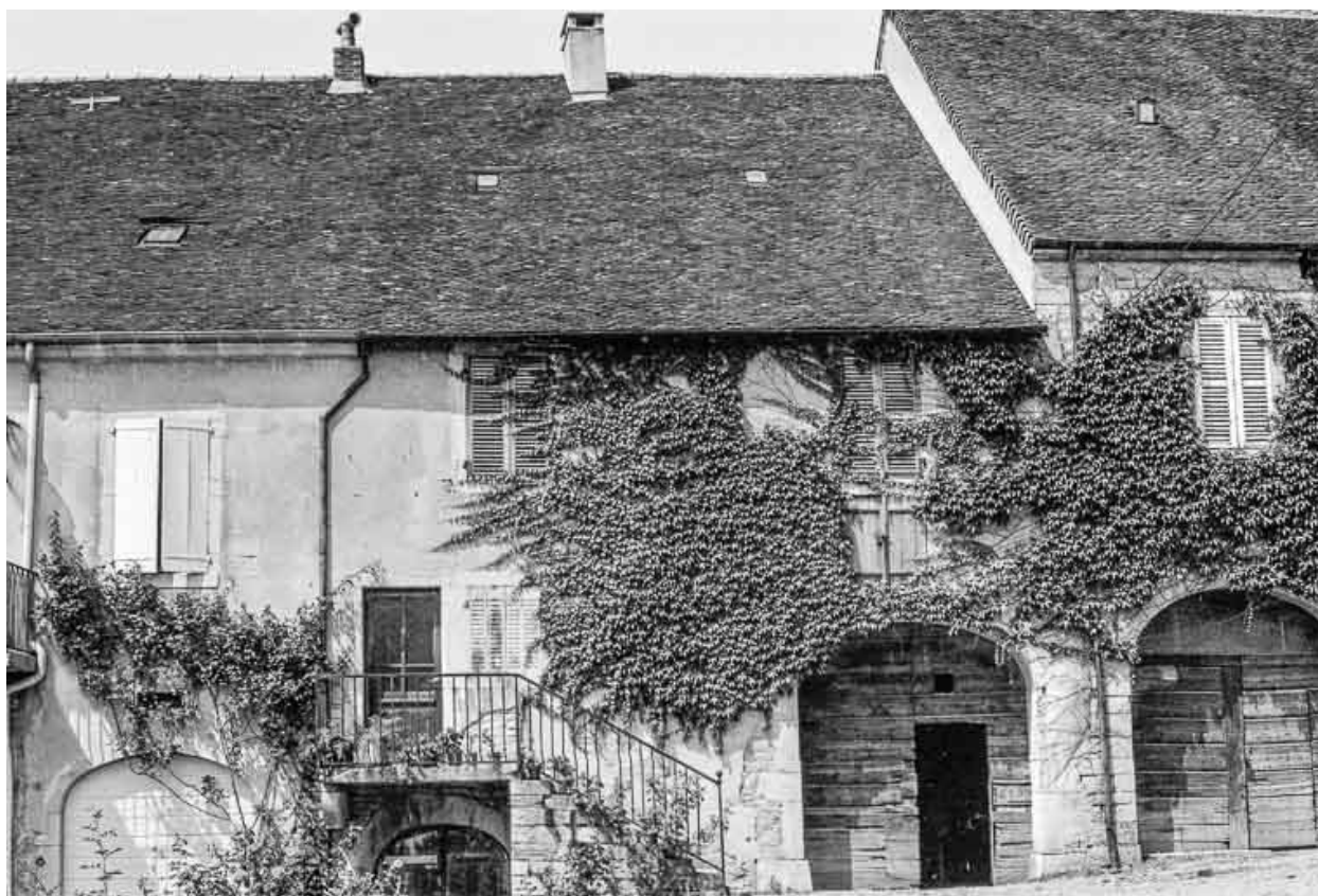
Maison de vigneron cadastrée AD 43 : façade antérieure.
