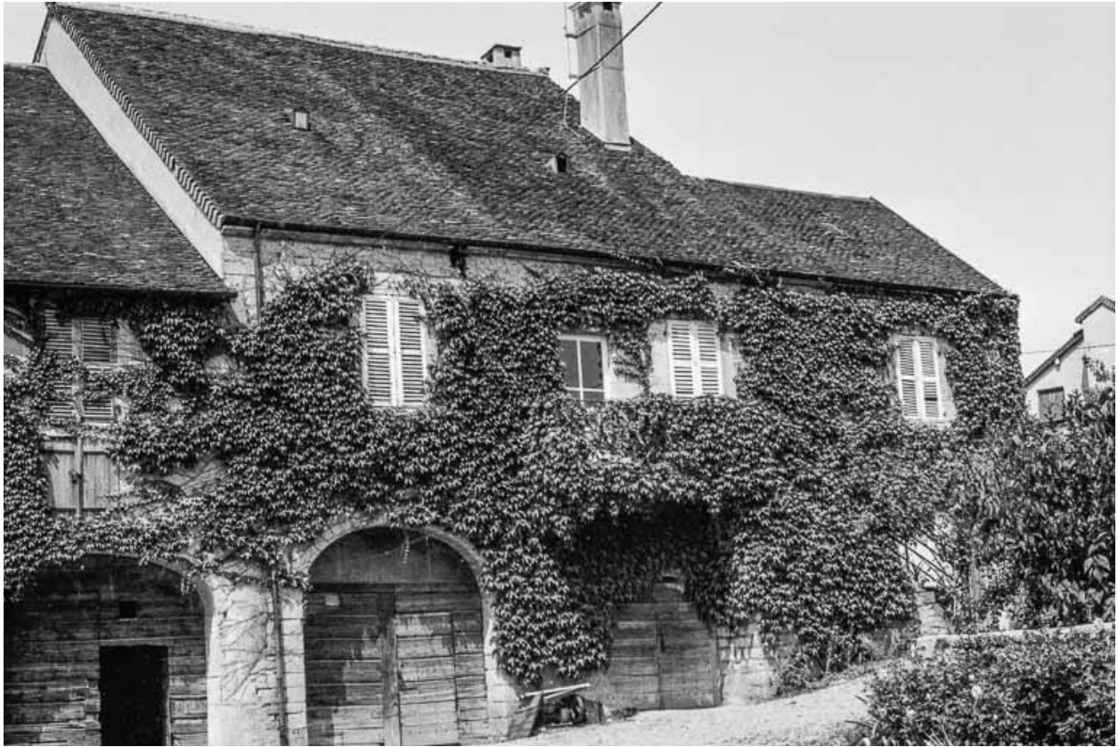
Maison de vigneron cadastrée AD 44 : façade antérieure.
