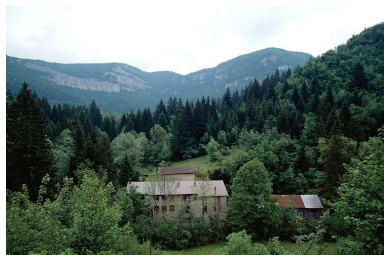
Vue d'ensemble depuis l'ouest. Phot. Yves Sancey IVR43_19913900808ZA
