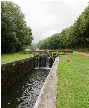
Vue du sas et du déversoir. Phot. Pierre-Marie Barbe-Richaud IVR26_20175800262NUC2A
