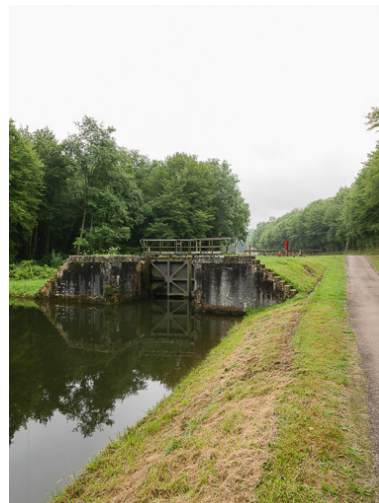
Vue du sas. Phot. Pierre-Marie Barbe-Richaud IVR26_20175800261NUC2A
