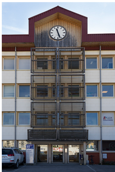
Usine : travées centrales de la façade antérieure.
