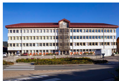
Usine : façade antérieure.
