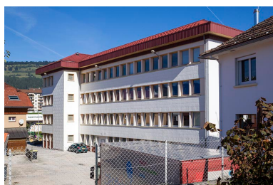
Usine : façade latérale droite, vue en enfilade. Phot. Yves Sancey IVR43_20132502193NUC2A
