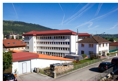
Vue d'ensemble, depuis la rue Emile
