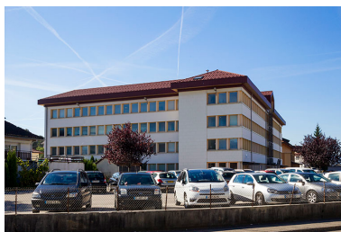
Usine : façade latérale gauche, de trois quarts.
