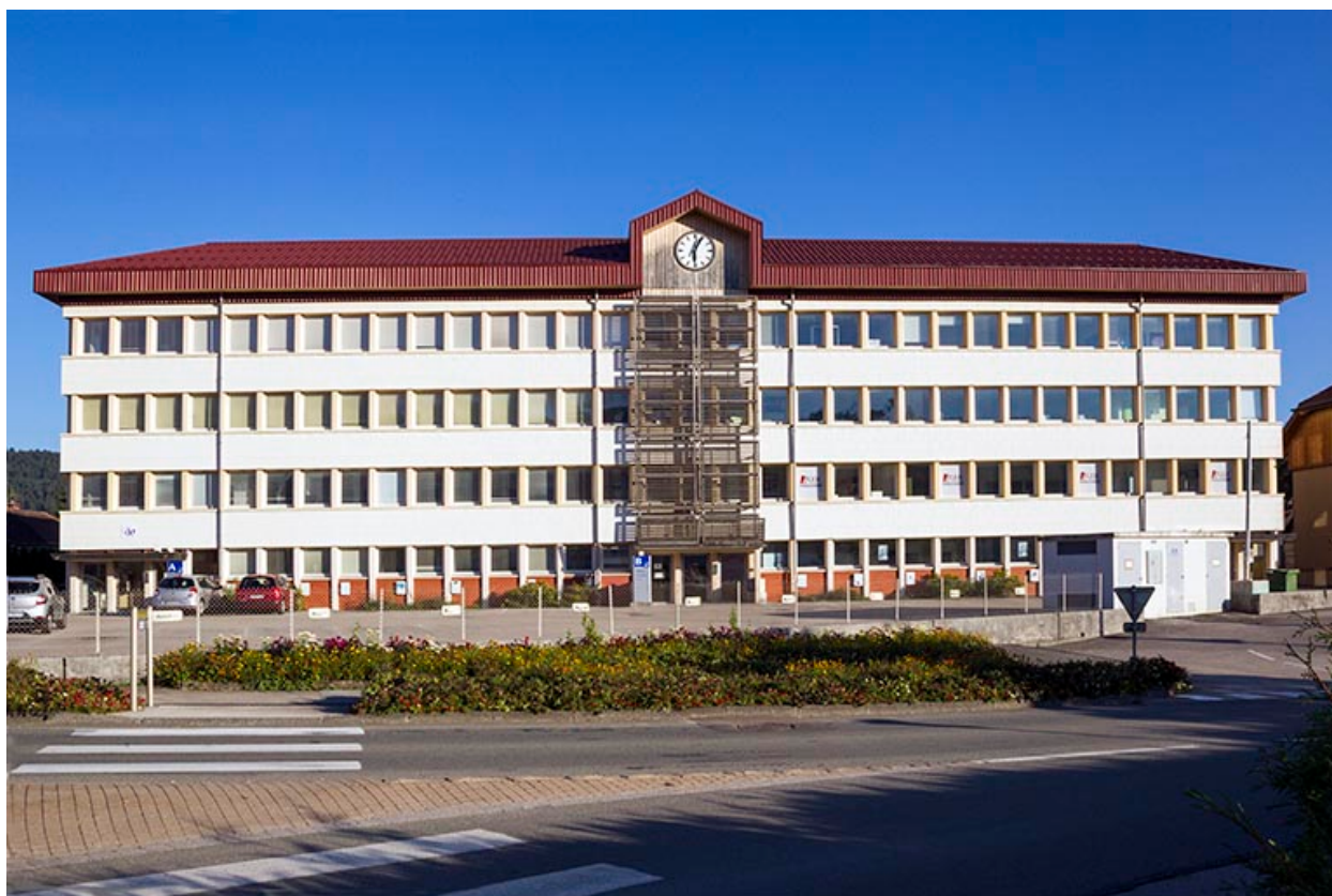
Usine : façade antérieure.
