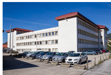
Usine : façades postérieure et latérale gauche.
