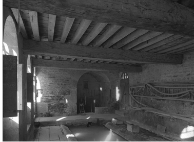
Vue intérieure. Lavoir. Phot. Michel Thierry IVR26_19748900718V
