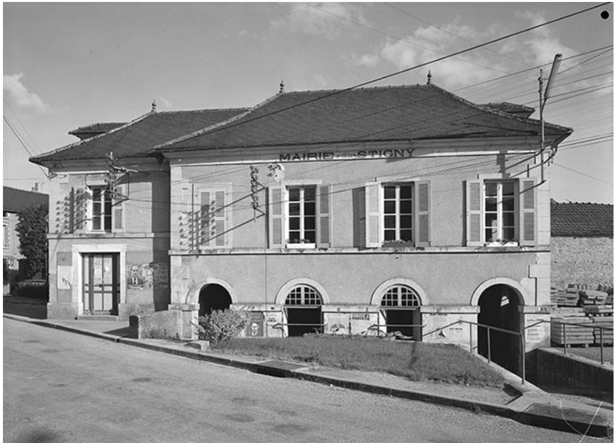
Façade principale avec lavoir en rez-de-chaussée.
