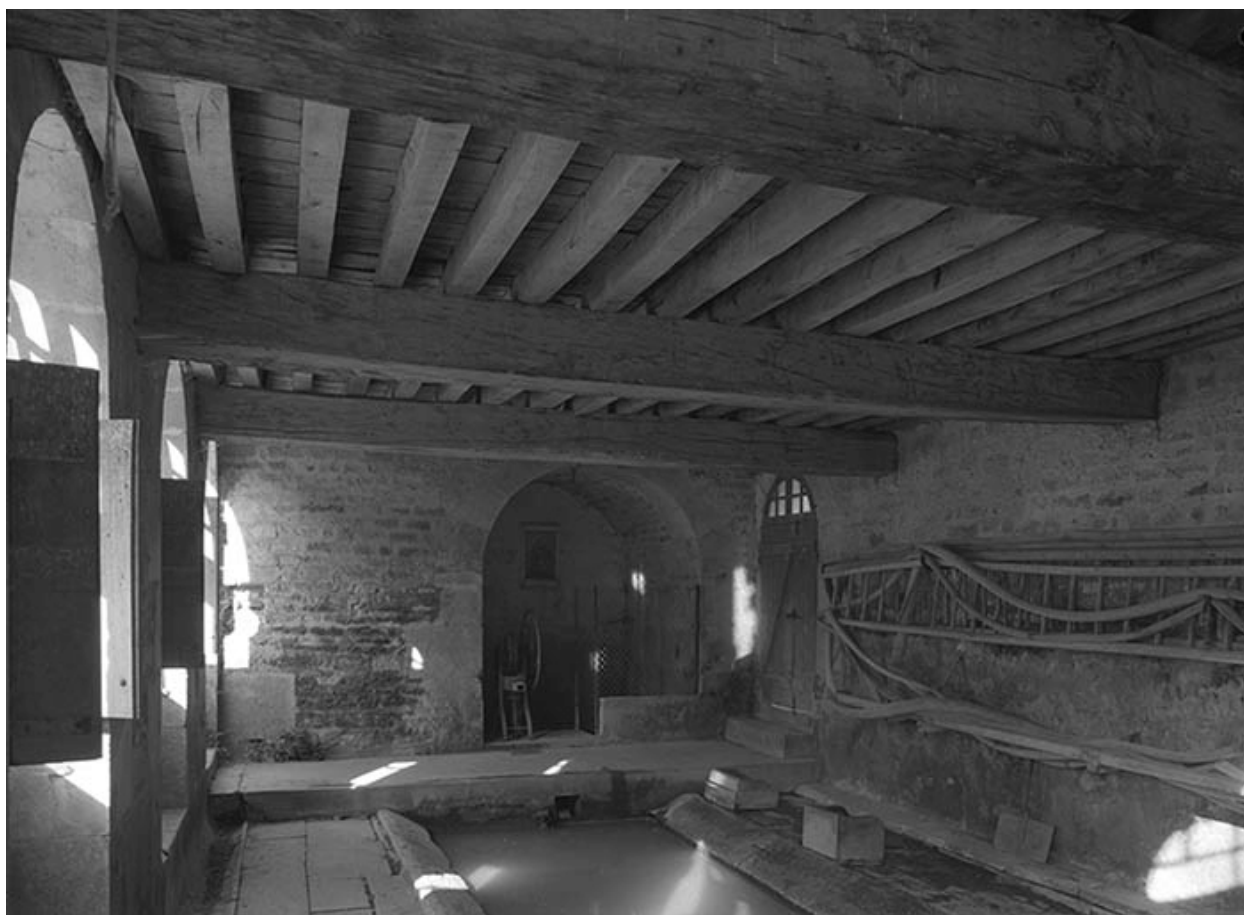
Vue intérieure. Lavoir.
