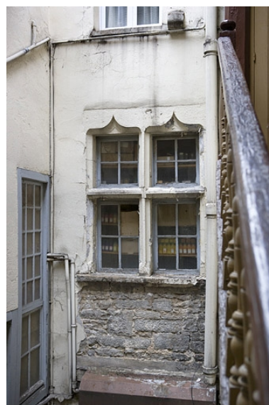
Logis secondaire : détail de la fenêtre en accolade sur cour.
