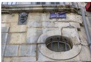
Détail de l'oculus au-dessus du linteau de porte du logis secondaire, rue des Boucheries. Phot. Yves Sancey IVR43_20102500206NUC2A
