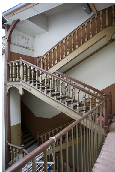
Vue d'ensemble de l'escalier à cage ouverte sur cour.
