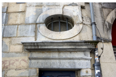
Détail du linteau de porte avec inscription du logis secondaire, rue des Boucheries. Phot. Yves Sancey IVR43_20102500205NUC2A
