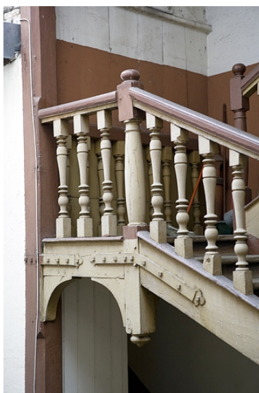
Détail des balustres de l'escalier à cage ouverte sur cour.
