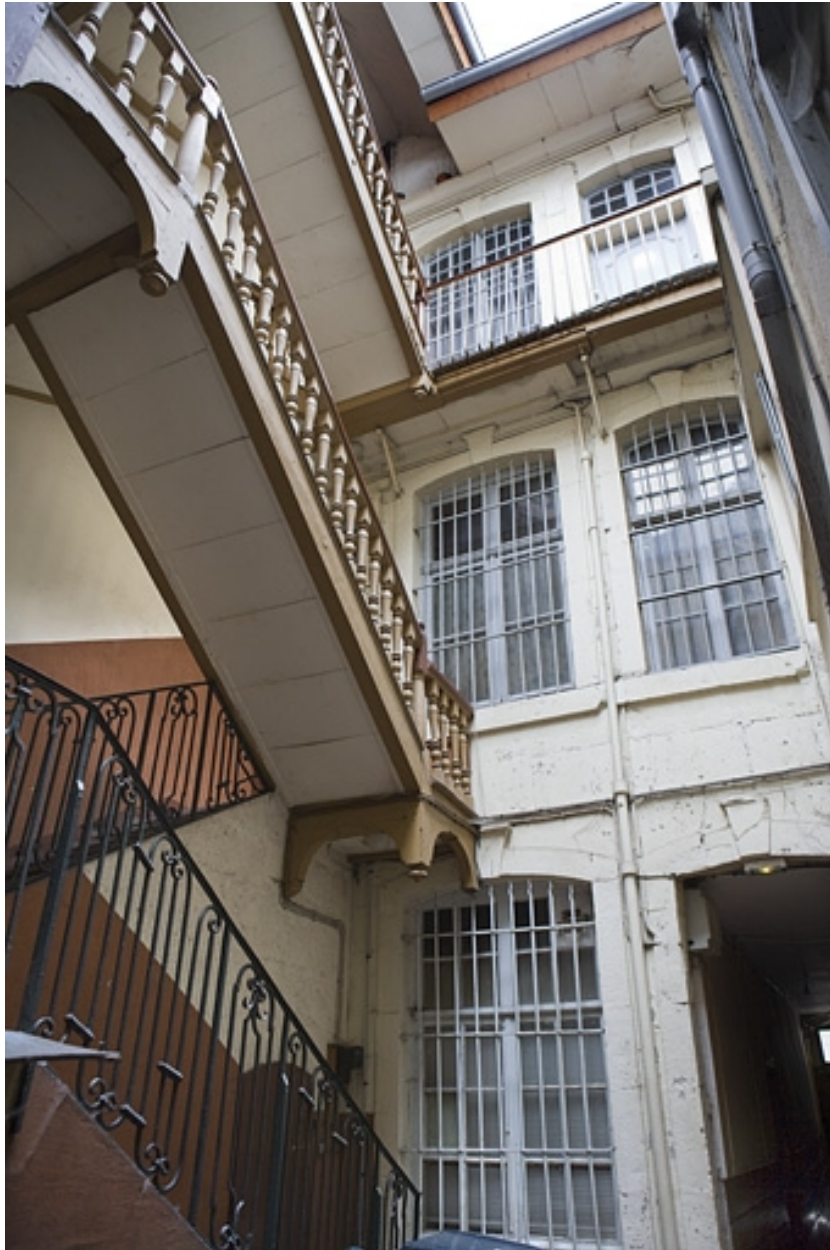
Façade postérieure du logis principal.
