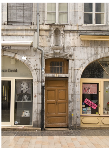
Détail de la porte d'entrée. Phot. Yves Sancey IVR43_20102500199NUC2A
