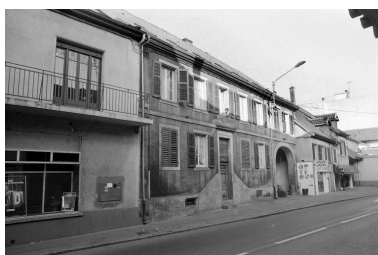
Maison située 59 Grande Rue. Phot. Bernard Lardière IVR43_19832500165Z
