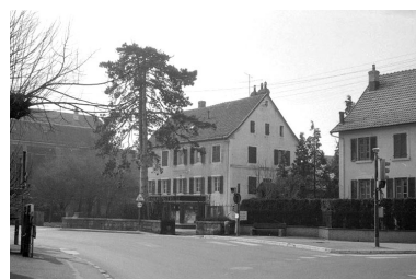
Maison située 74 Grande Rue. Phot. Bernard Lardière IVR43_19832500204Z
