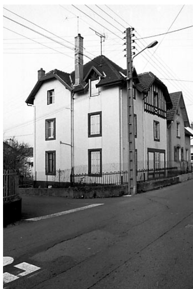
Maison située 20 rue Romaine. Phot. Bernard Lardière IVR43_19832500250Z
