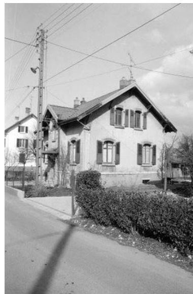
Maison située 15 rue des Arbues. Phot. Bernard Lardière IVR43_19832500253Z
