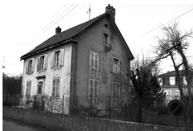
Maison située 8 rue des Serruriers. Phot. Bernard Lardière IVR43_19832500237Z
