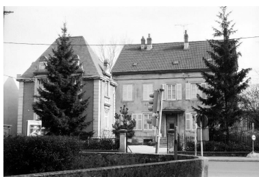
Maison située 101 Grande Rue. Phot. Bernard Lardière IVR43_19832500234Z
