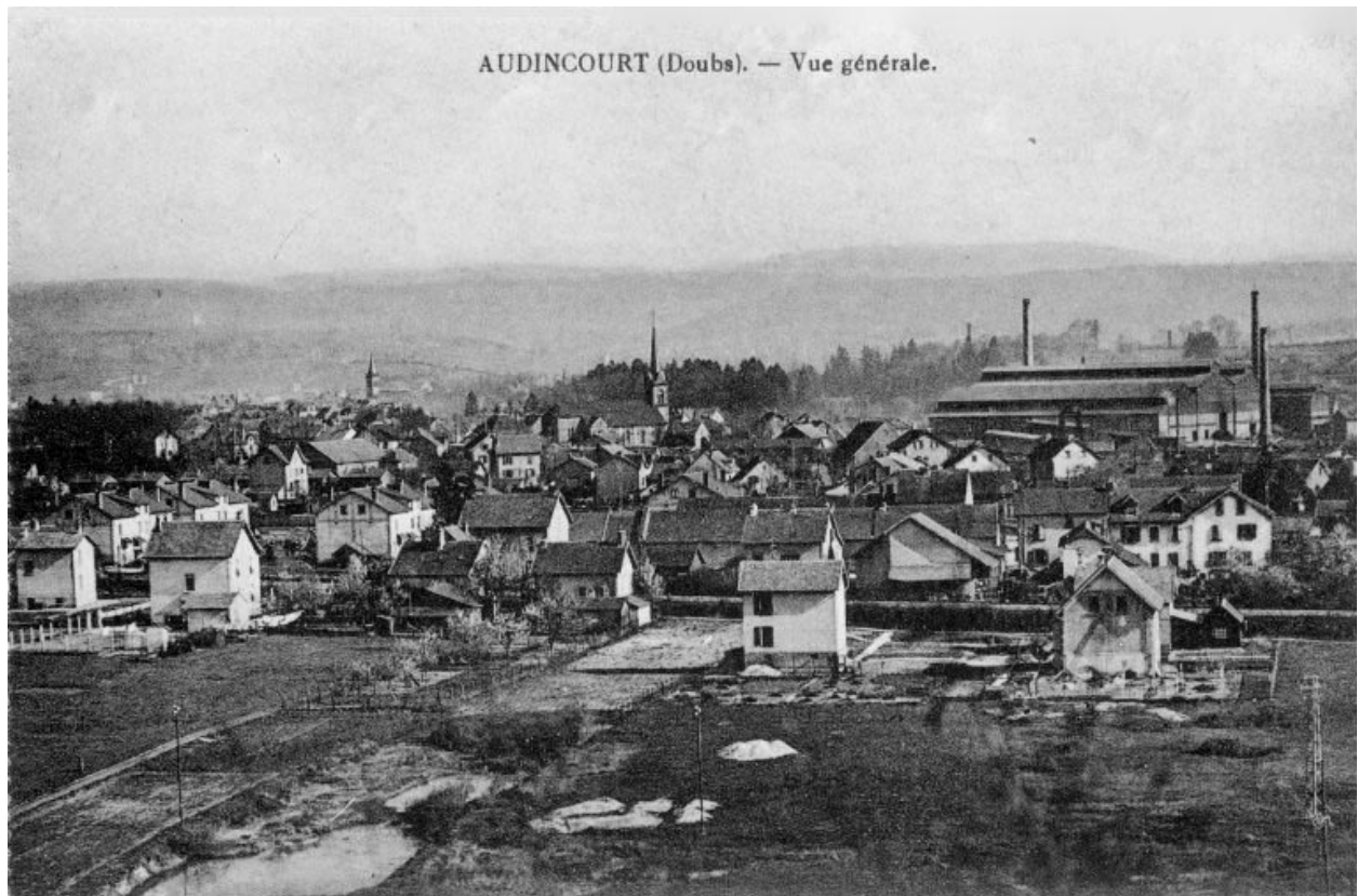
AUDINCOURT (Doubs) - Vue générale.
