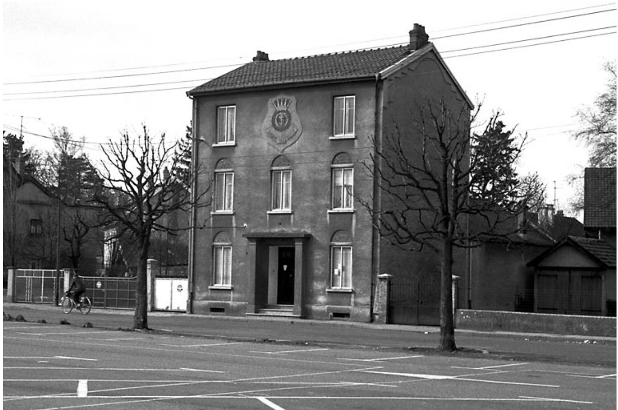
Maison située 6 rue du Docteur Duvernoy.
