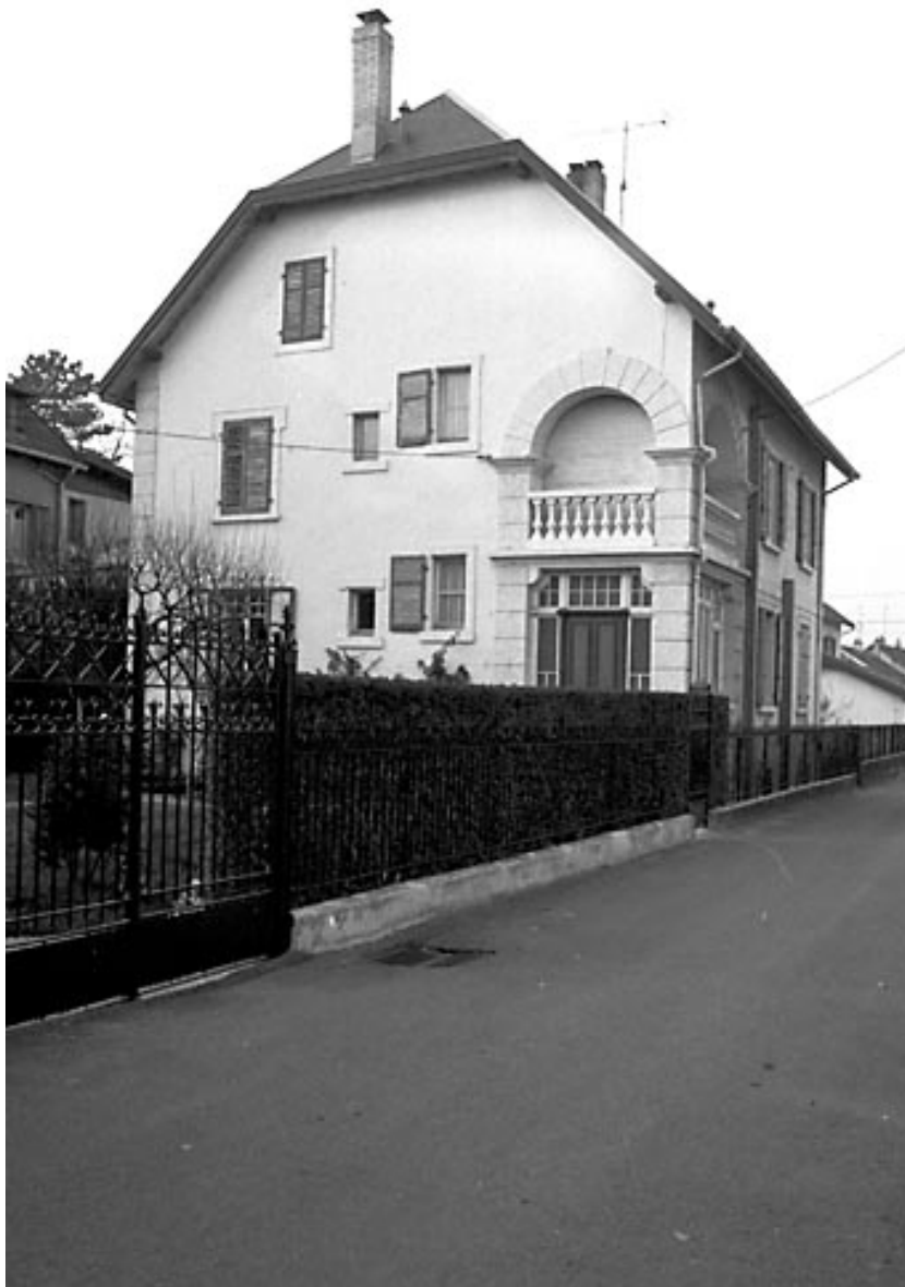
Maison située 6 rue du 11 Novembre.
