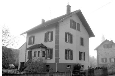
Maison située 21 rue Jeanne d'Arc. Phot. Bernard Lardière IVR43_19832500283Z
