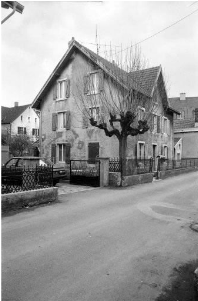
Maison située 2 rue de la Musique.
