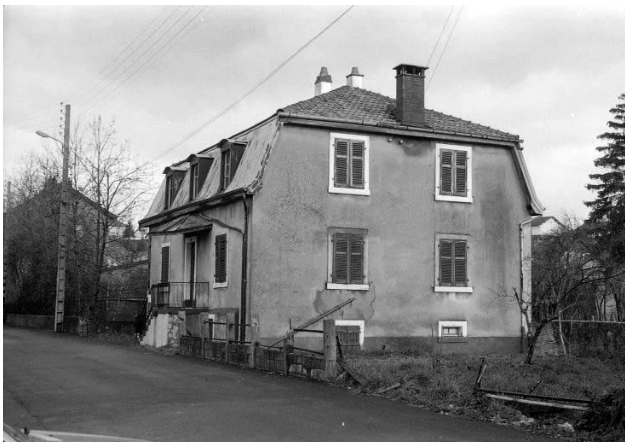
Maison située 5 rue de Soissons.
