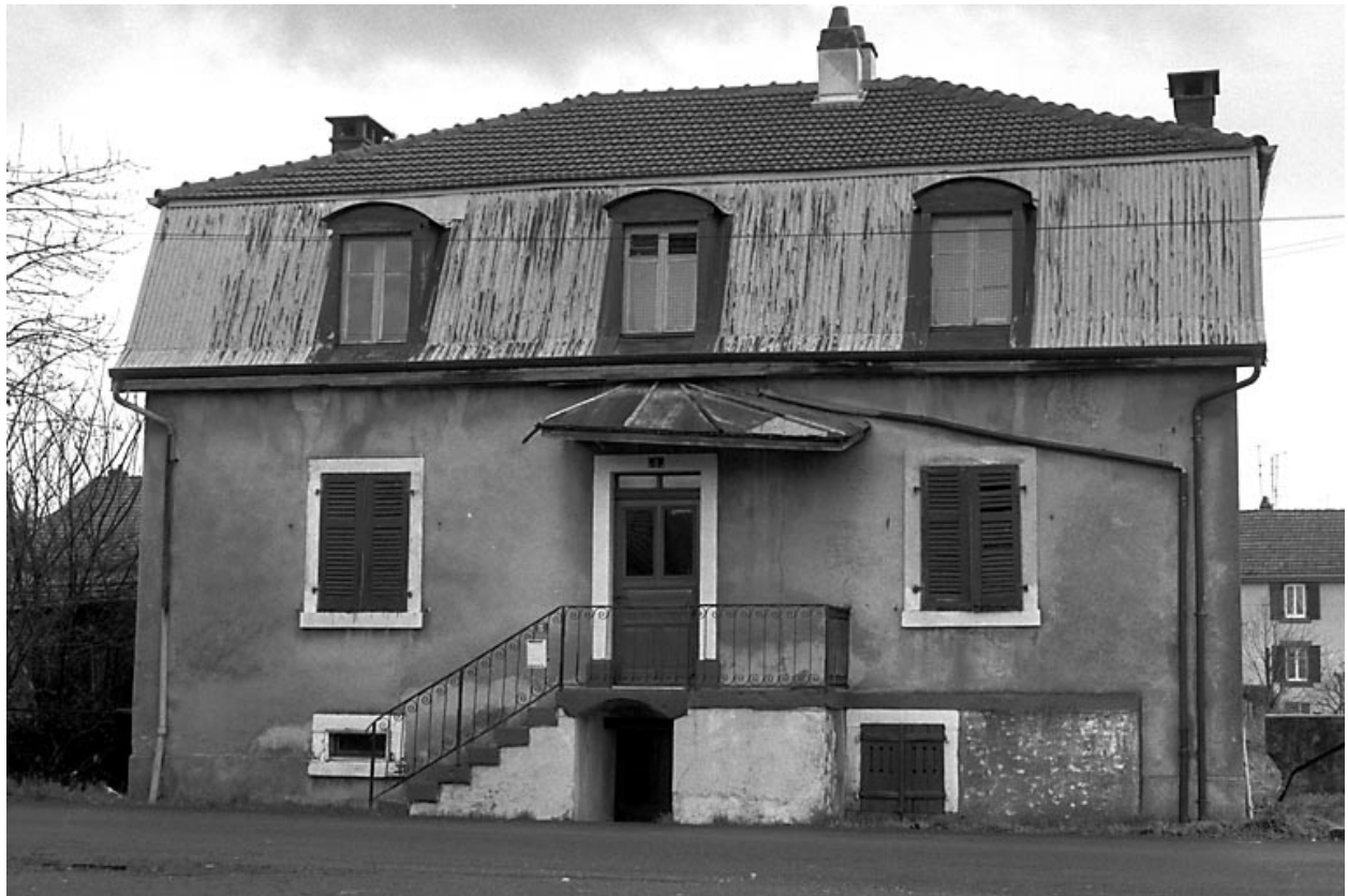
Maison située 5 rue de Soissons.
