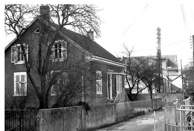
Maison située 5 rue des Serruriers. Phot. Bernard Lardière IVR43_19832500241Z
