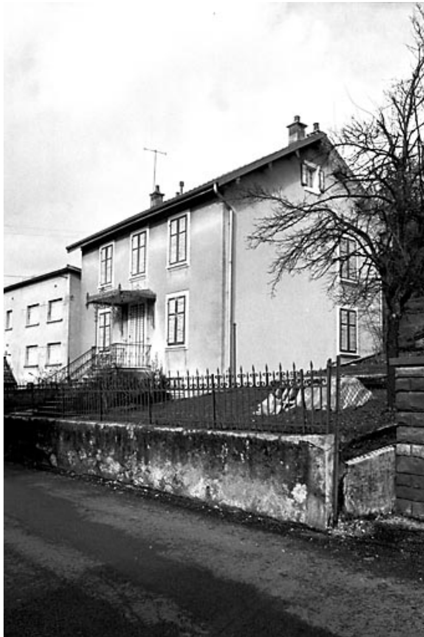
Maison située 13 rue sous les Vignes.
