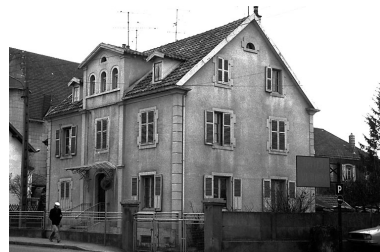
Maison située 7 Grande Rue. Phot. Bernard Lardière IVR43_19832500240Z
