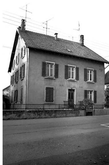
Maison située 34 rue Romaine. Phot. Bernard Lardière IVR43_19832500217Z
