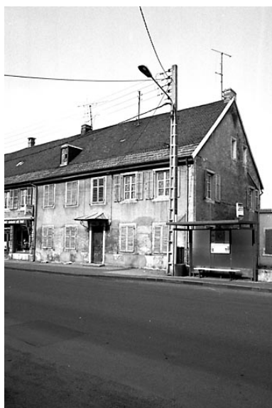
Maison située 13 Grande Rue. Phot. Bernard Lardière IVR43_19832500308Z
