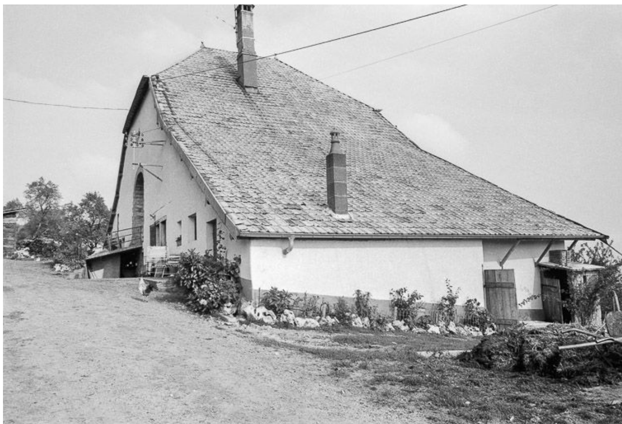
Ferme située chemin de la Vierge : façades antérieure et latérale droite.
