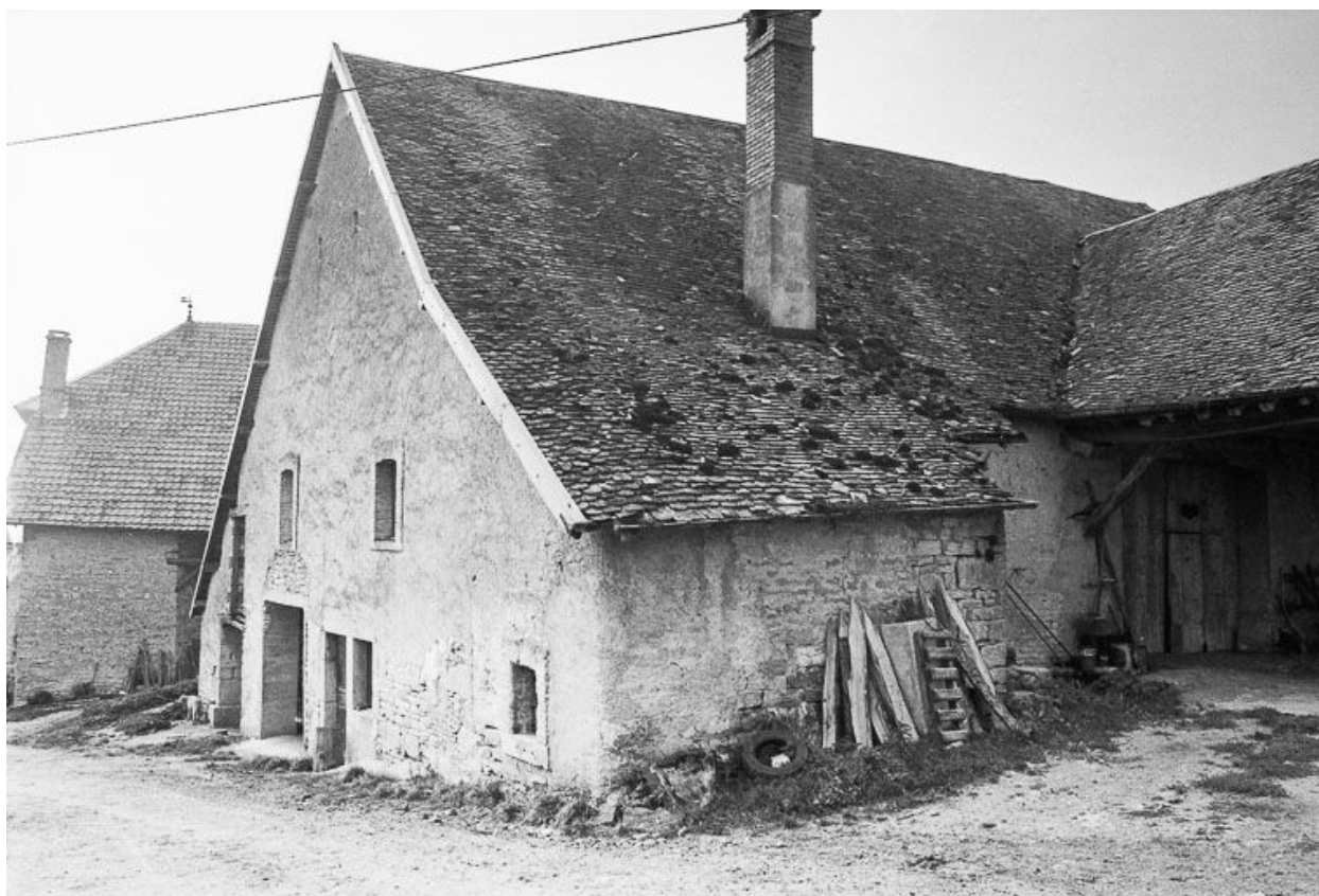
Ferme : vue de la partie habitation.
