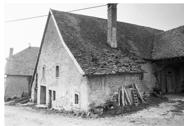
Ferme : vue de la partie habitation. Phot. Liliane Hamelin IVR43_19762500960Z
