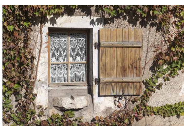
Maison, ancienne auberge et relais de poste, 3 rue des Glacis, détail : la fenêtre de la cuisine avec la sortie d'évier (ou goulotte).
