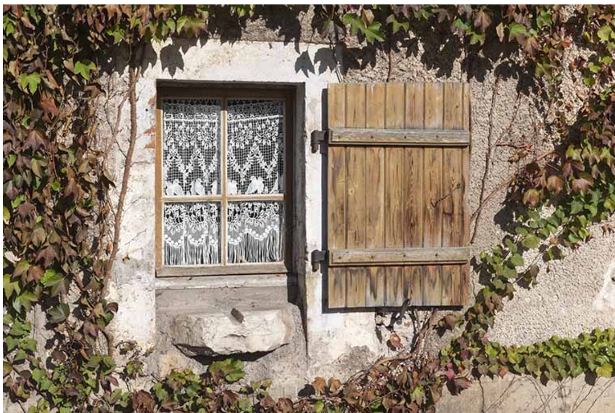
Maison, ancienne auberge et relais de poste, 3 rue des Glacis, détail : la fenêtre de la cuisine avec la sortie d'évier (ou goulotte).
