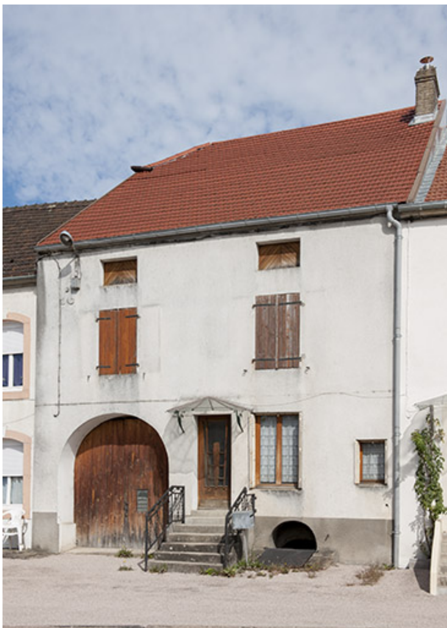
Ferme, 3 rue Arago : ferme à deux travées.
