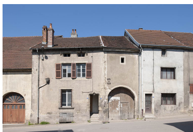
Maison, 25 et 27 Grande Rue. Phot. Jérôme Mongreville IVR43_20127000111NUC4A
