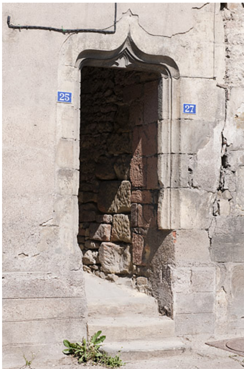
Maison 25 et 27 Grande Rue : la porte, qui ouvre sur un couloir traversant menant à la cour, possède un linteau en accolade (17e siècle ?).
