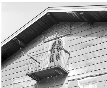
Façade latérale droite : porte haute et balcon. Phot. Yves Sancey IVR43_20033900439X
