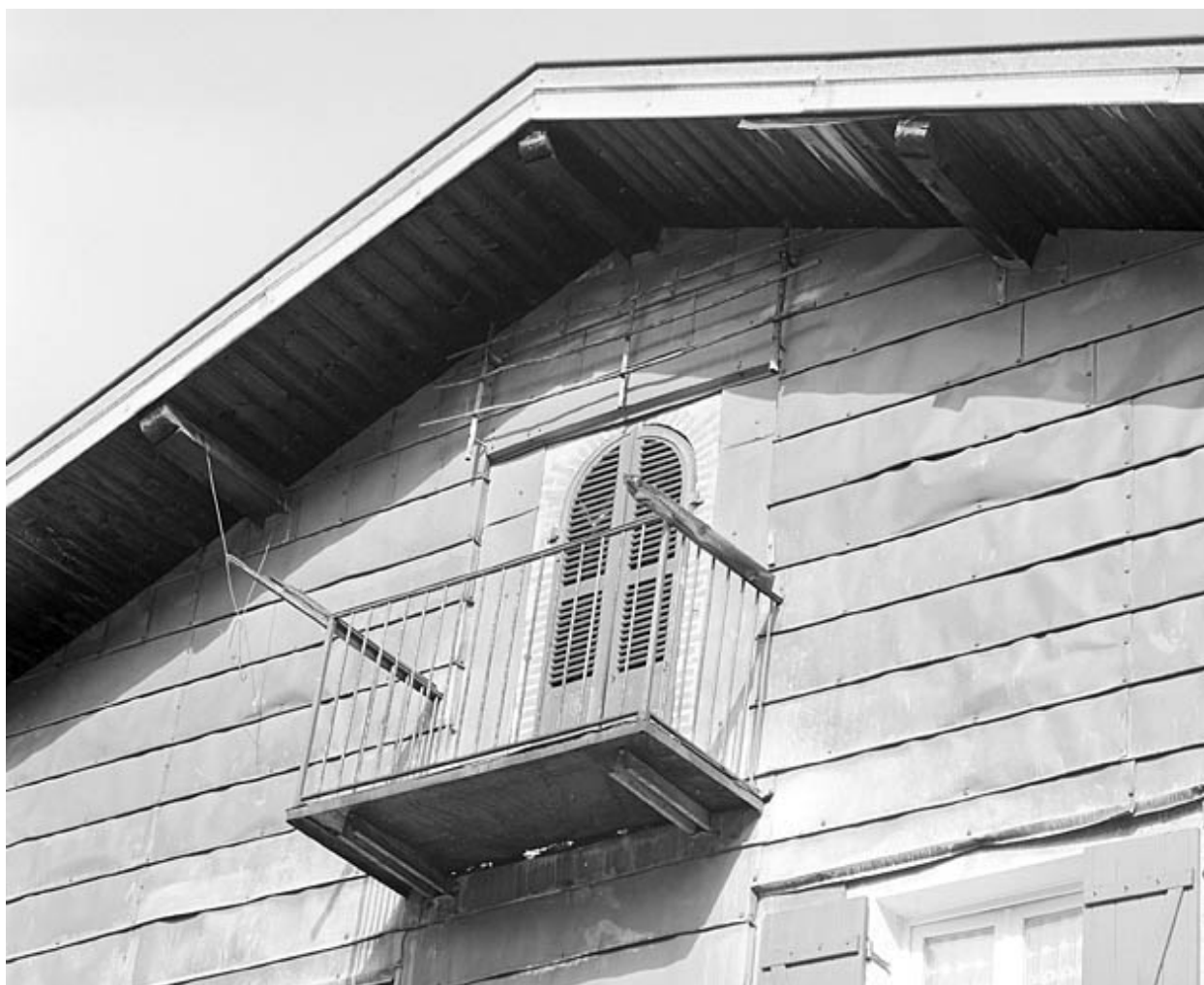
Façade latérale droite : porte haute et balcon.
