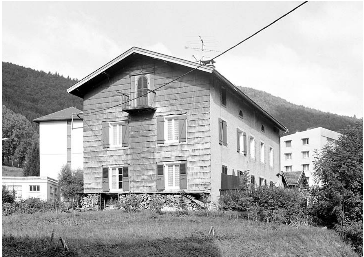
Façades postérieure et latérale droite.
