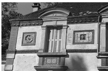
Détail de la façade sud : panneaux de céramique encadrant une baie de l'étage en surcroît (provenance indéterminée). Phot. Frédéric Pillet IVR26_19997100735Z
