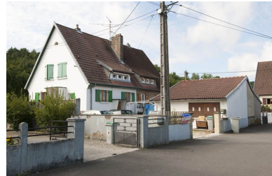
Maison et garage vus de trois quarts. Phot. Jérôme Mongreville IVR43_20112502174NUC4A
