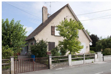
Maison à étage en surcroît. Phot. Jérôme Mongreville IVR43_20112502178NUC4A
