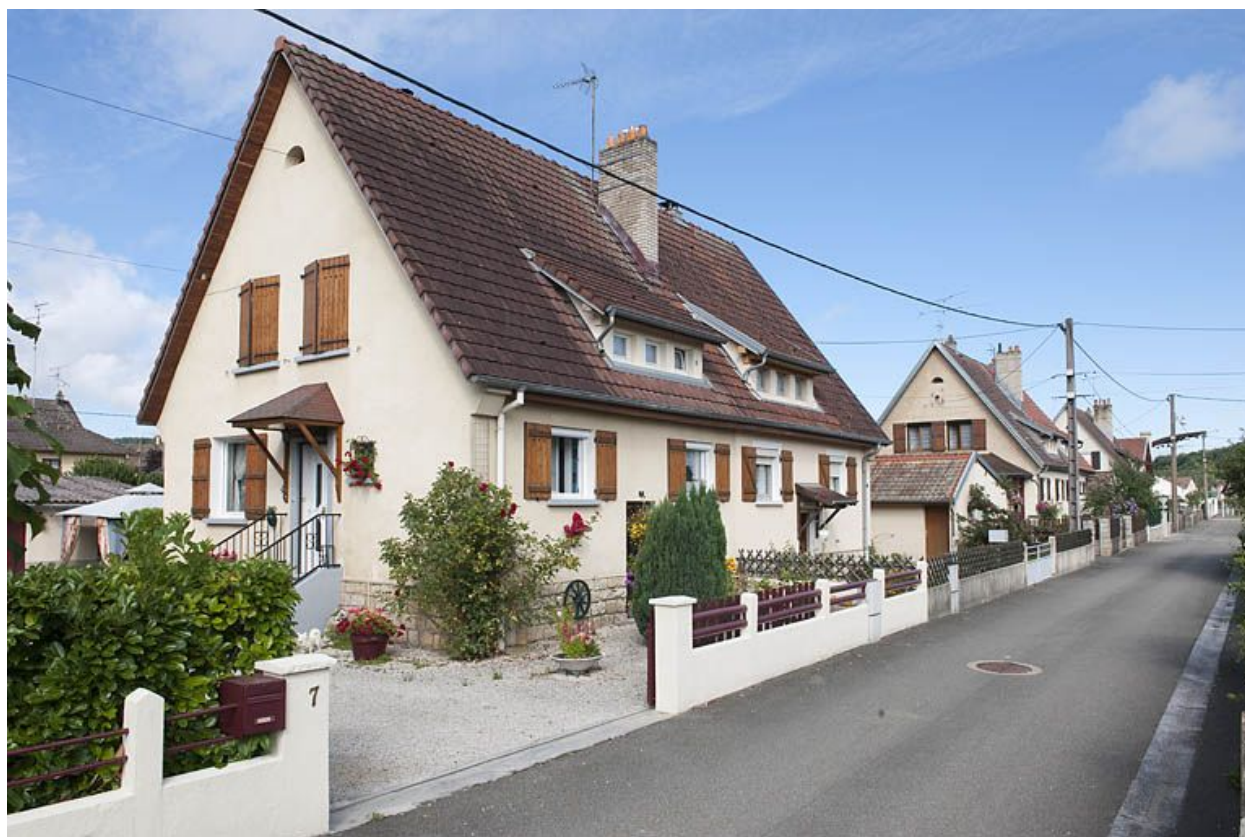
Vue d'ensemble d'une rue.
