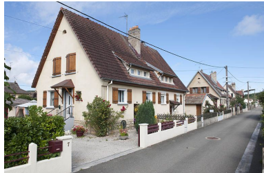
Vue d'ensemble d'une rue. Phot. Jérôme Mongreville IVR43_20112502177NUC4A
