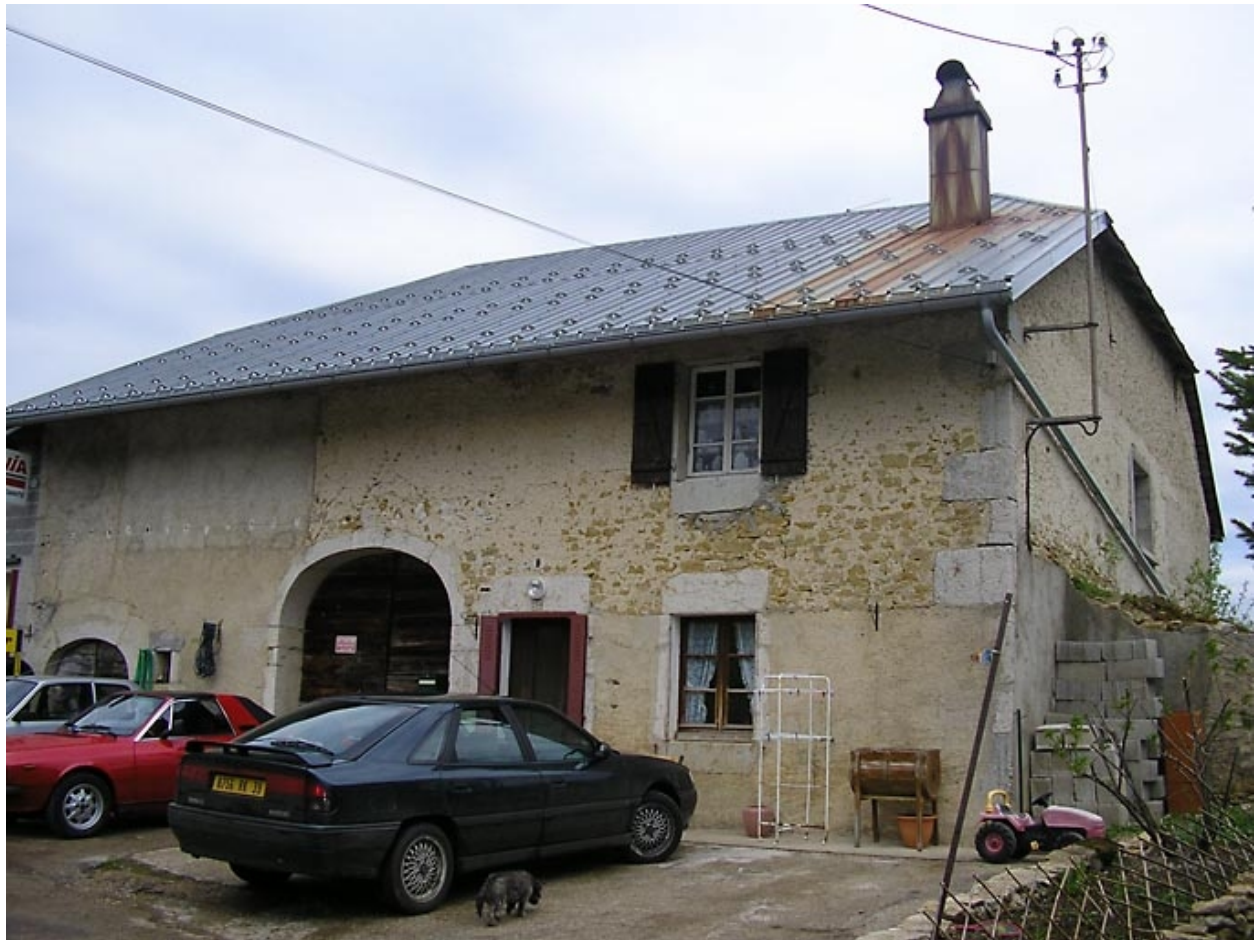
Façade antérieure vue de trois quarts.
