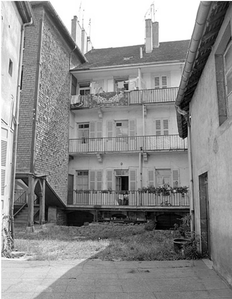
Façade postérieure montrant l'escalier à gauche.
