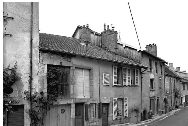
Façade antérieure vue de trois quarts gauche.
