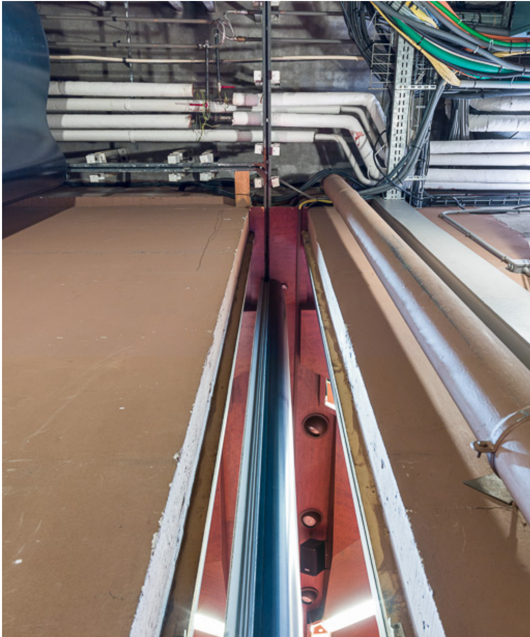
Salle des Assemblées : vue du système de rails pour faire coulisser manuellement la cloison.
