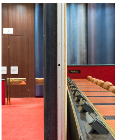
Salle des Assemblées : cloison coulissante de séparation, avec le système d'accroche des panneaux sur des planches de bois aggloméré. Phot. Pierre-Marie Barbe-Richaud IVR26_20142102180NUC2A
