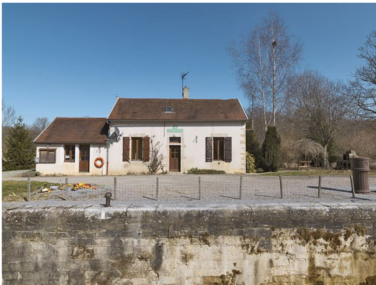
La maison éclusière de face.
