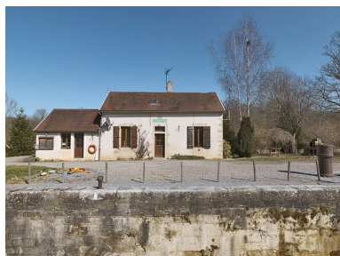
La maison éclusière de face. Phot. Thierry Kuntz IVR26_20122102578NUC4A
