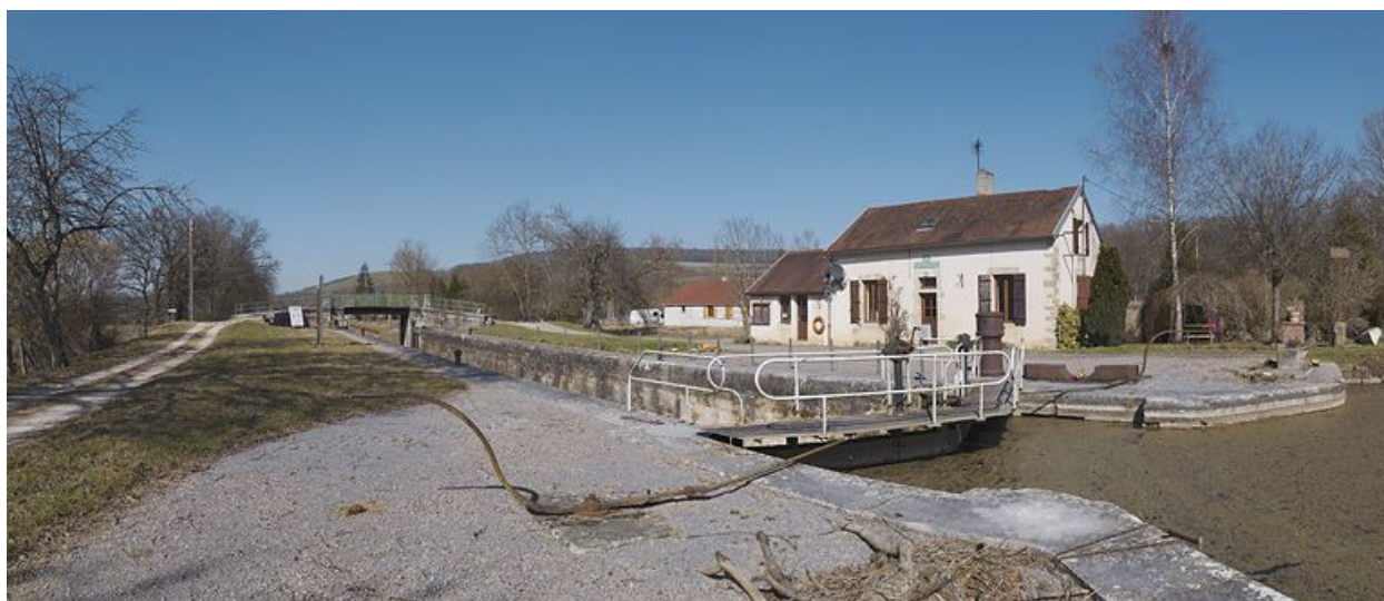
Le site d'écluse vu d'amont.
