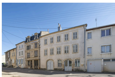
La façade dans son environnement urbain. Phot. Jérôme Mongreville IVR43_20217000682NUC4A
