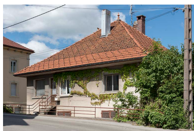
Façade postérieure (rue du Maréchal Foch).
