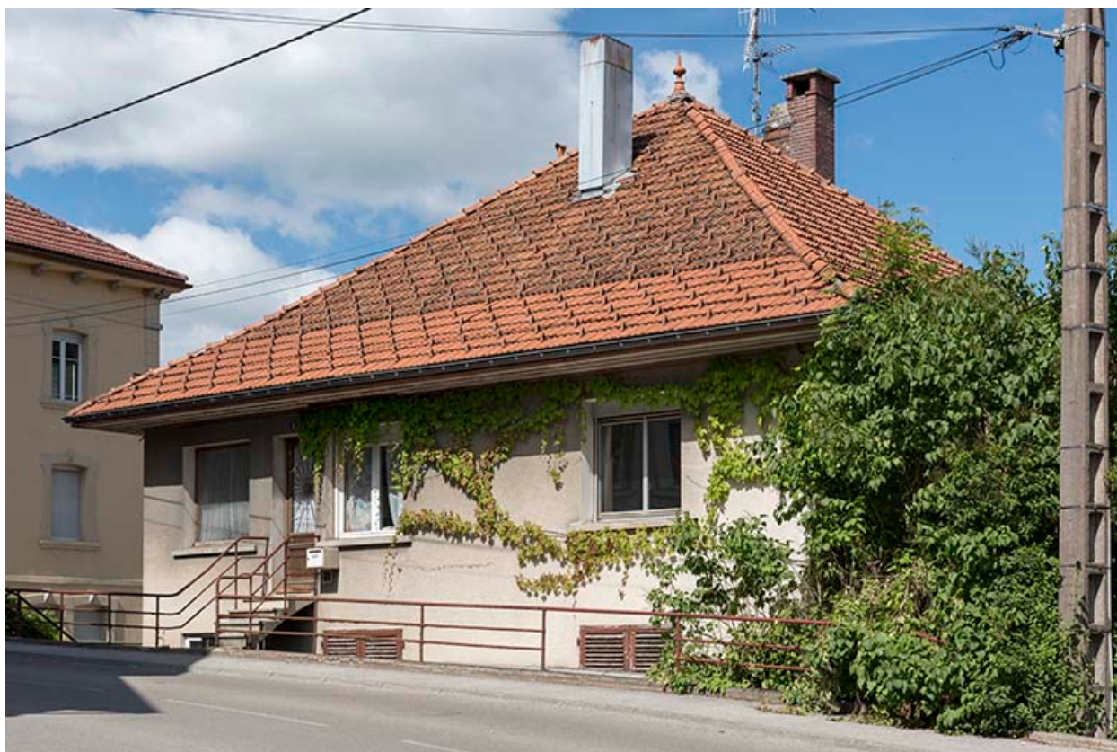
Façade postérieure (rue du Maréchal Foch).
