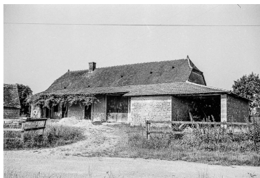
Ferme : vue générale. Phot. Guy Forestier IVR43_19753900362Z
