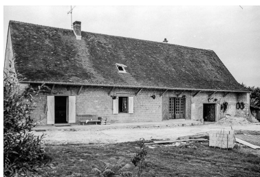
Ferme : façade antérieure. Phot. Guy Forestier IVR43_19753900359Z
