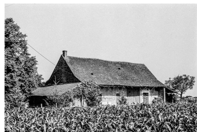
Ferme : vue générale. Phot. Guy Forestier IVR43_19753900364Z
