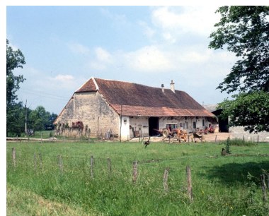
Ferme située chemin de la Coupe de France : vue d'ensemble. Phot. Yves Sancey IVR43_19903901173XA
